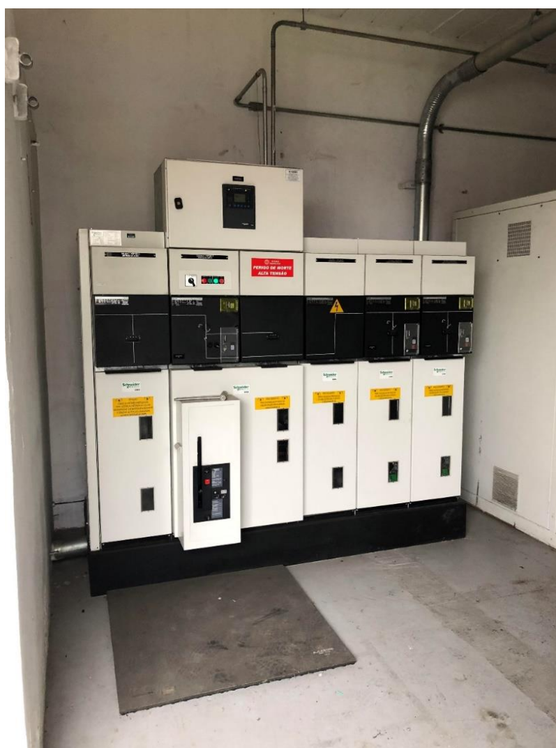
Figura 3: Subestação blindada
