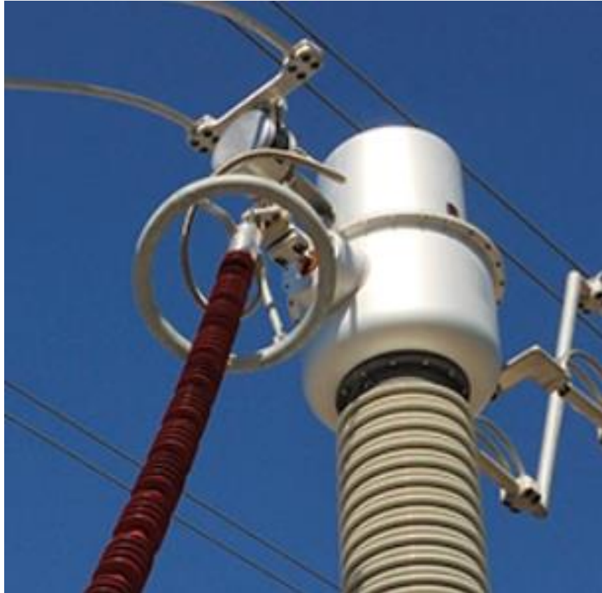
Figura 10A: Transformador de corrente óptico
