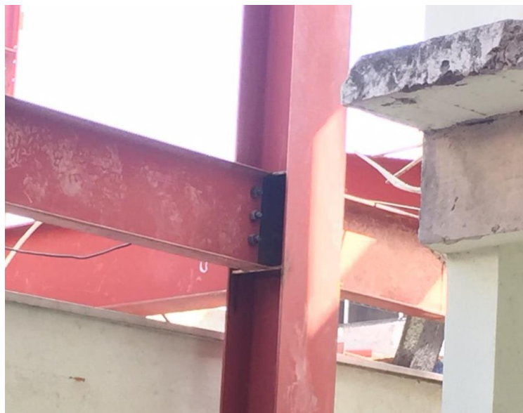
Figura 28 - Ligação LCSP realizada no canteiro de obras. Fonte: Autores (2019).
