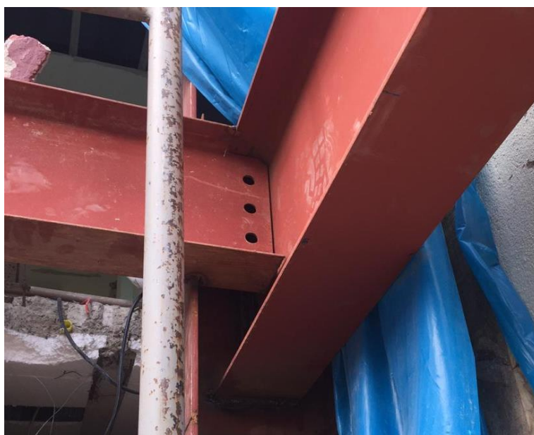
Figura 27 - Ligação LCPP realizada no canteiro de obras. Fonte: Autores (2019).
