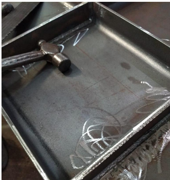
Figura 29 - Ponteamento de solda no enrijecedor na alma. Fonte: Autores (2019).
