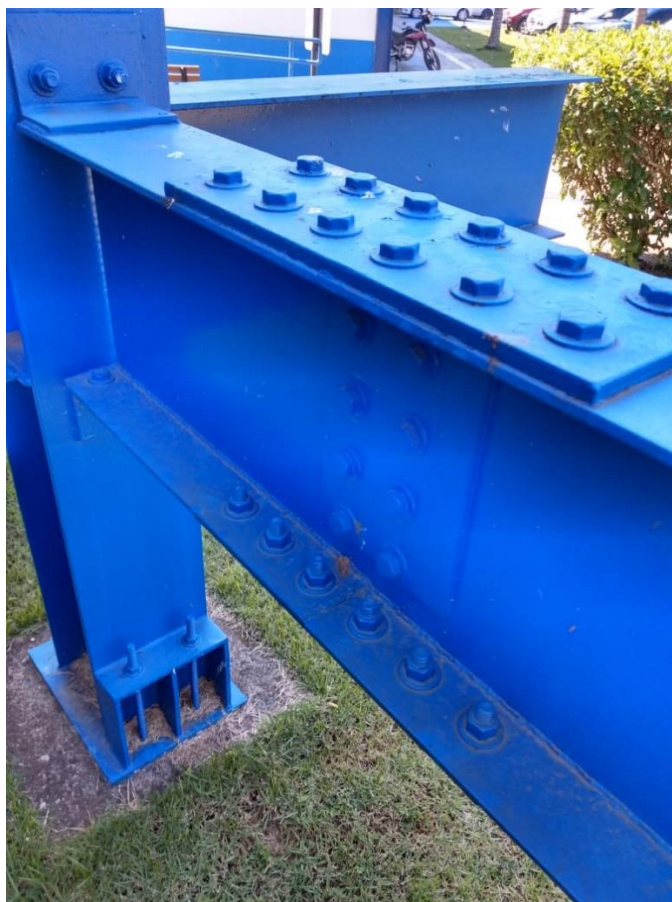
Figura 4 - Modelo de conexões parafusadas. Fonte: Autores (2019).
