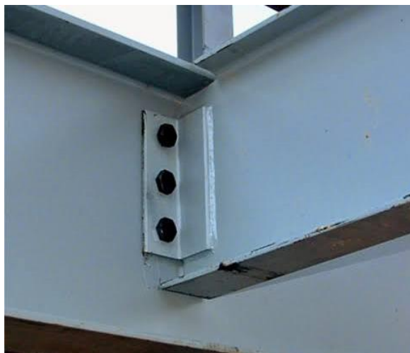
Figura 23 - Ligação flexível com cantoneira - LCPP. Fonte: Autores (2019).
