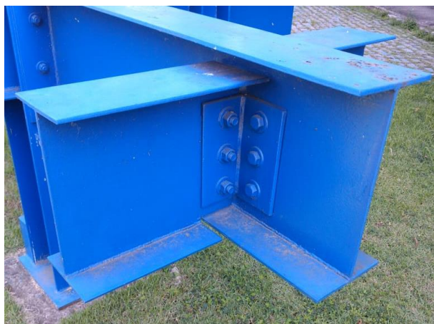
Figura 22 - Ligação flexível com cantoneira – LCPP Fonte: Autores (2019).
