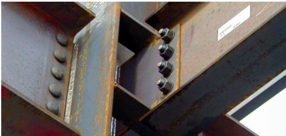
Figura 30 - Ligação rígida - LMSS. Fonte: Guia da Engenharia (2019)
