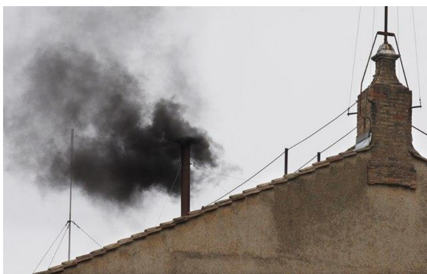
Figura 45 - Saída dos gases pela chaminé. Fonte: Último segundo - IG.
