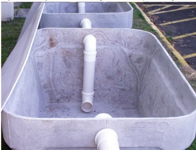
Figura 17: Aplicação da tubulação nas caixas de água da fossa séptica biodigestora
