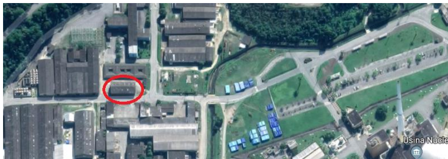
Figura 21: Localização do galpão
