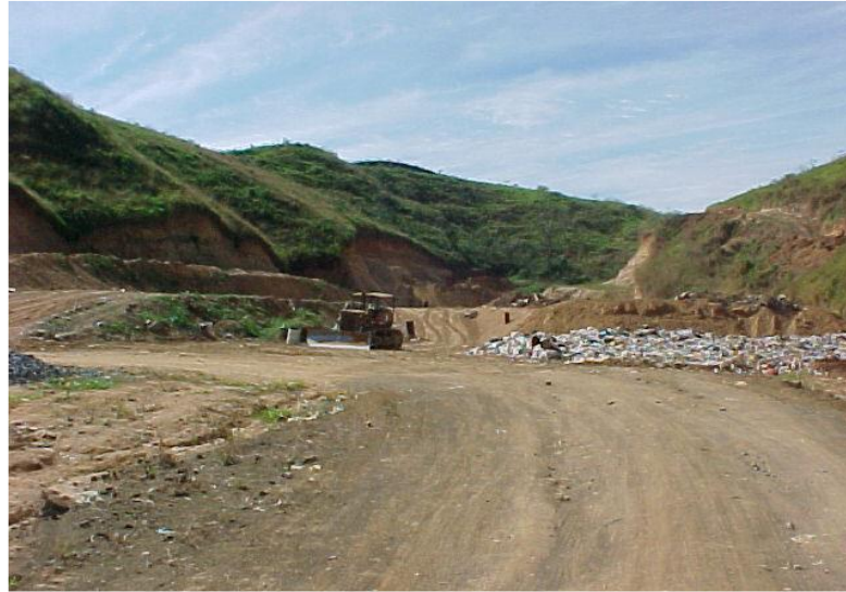
Figura 04: Funcionamento do Aterro Sanitário de Pirai-RJ Fonte: MARQUES, 2010.
