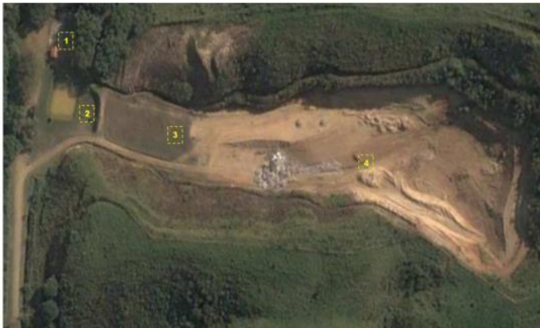
Figura 03: Vista aérea do Aterro Sanitário de Pirai-RJ (1 instalação administrativa, 2 estação tratamento de chorume, 3 área encerrada e 4 área em operação).
