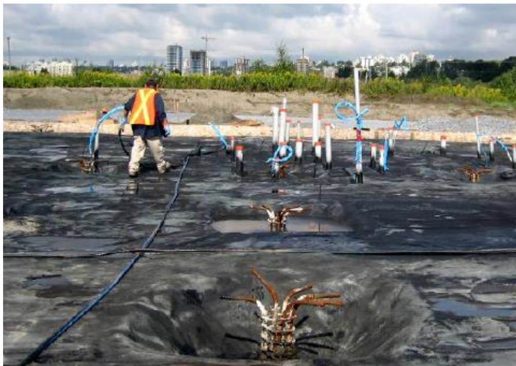
Figura 12: Instalação de barreira asfáltica. Fonte: Hers, 2010.
