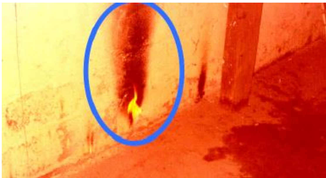
Figura 3: Combustão de gases e vapores provenientes de uma fonte subsuperficial. Fonte: Tamlinson, 2008, apud Gouvêa Jr., 2011.
