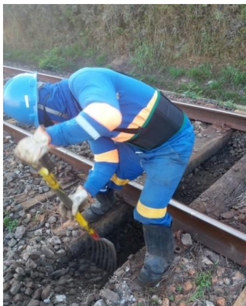
Figura 41: Abertura da cava.
