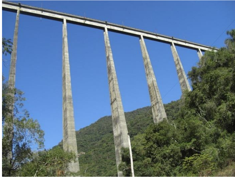
Figura 5: OAE Viaduto 13, Vespasiano Corrêa (Rio Grande do Sul).
