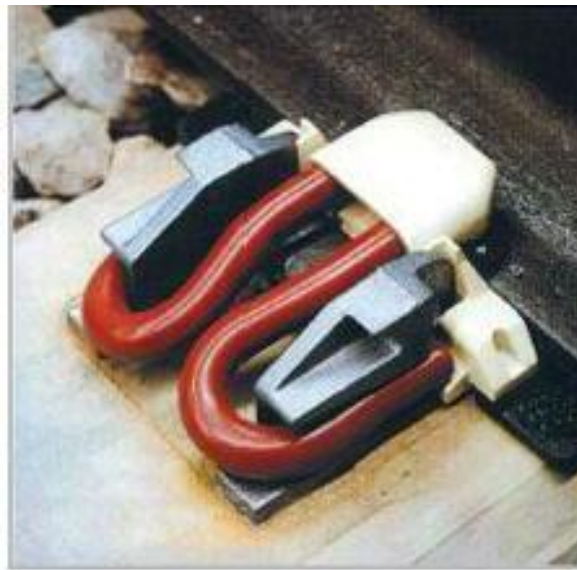
Figura 15: Grampo Fast-Clip para dormentes de aço.
