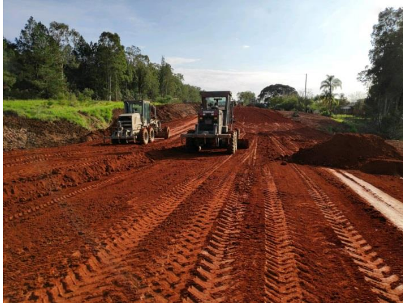
Figura 2: Terraplenagem 1º Batalhão Ferroviário.
