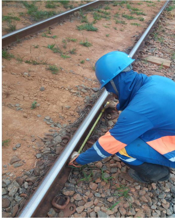
Figura 39: Medição e marcação do espaçamento dos novos dormentes.
