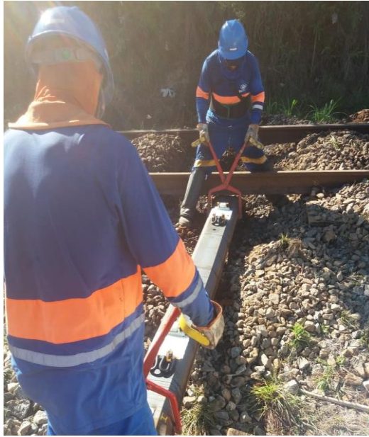
Figura 46: Inserção do dormente de aço na cava.
