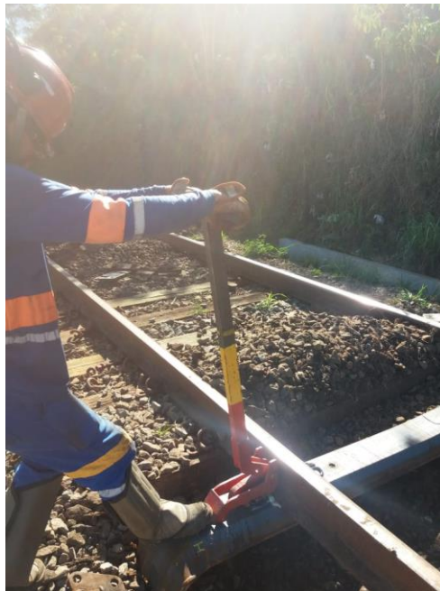
Figura 47: Ajustes nos componentes de fixação.
