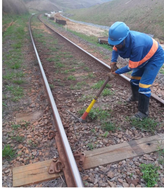
Figura 40: Remoção do lastro e vegetação da via.
