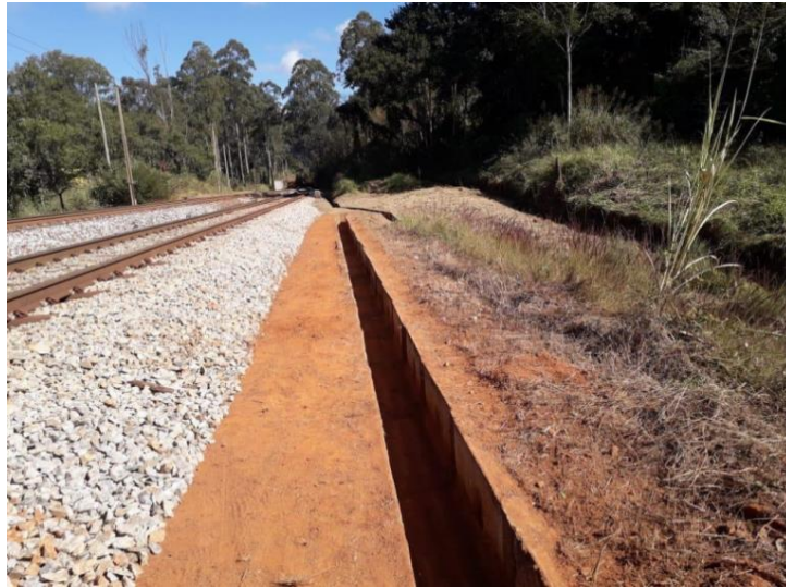
Figura 3: Valeta de drenagem ferroviária - Ferrovia do Aço.
