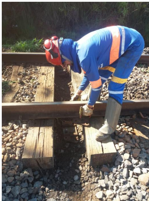
Figura 44: Extração da placa de apoio.
