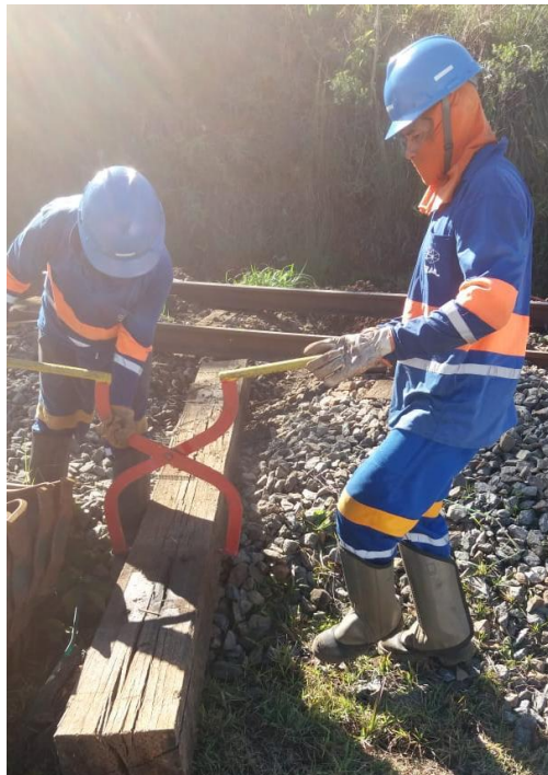
Figura 45: Extração do dormente de madeira.
