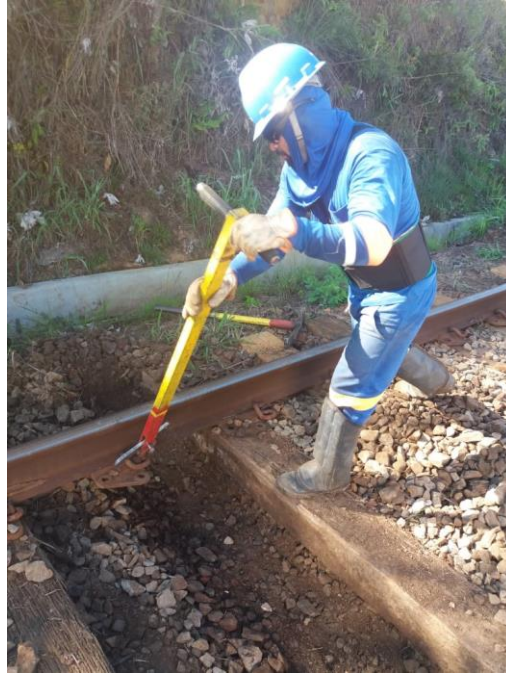
Figura 42: Remoção dos acessórios de fixação.
