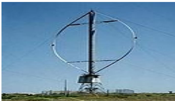
Figura 15 - Rotor Darrieus (Fonte: evolucaoenergiaeolica/2017)
