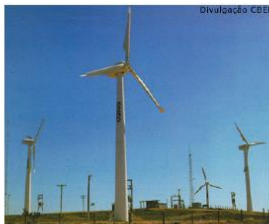
Figura 10 - Central Eólica instalada no Morro do Camelinho – Pesquisado em: < https://www.cemig.com.br >.
