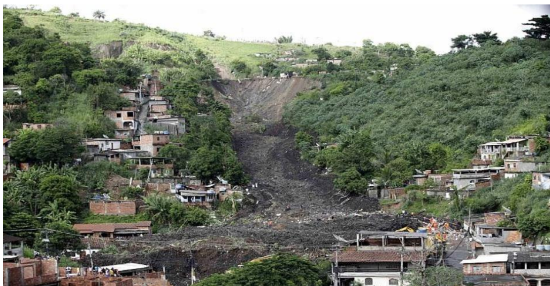
Figura 32 – Deslizamento de encosta com construções sobre antigo lixão em Niterói/RJ.
