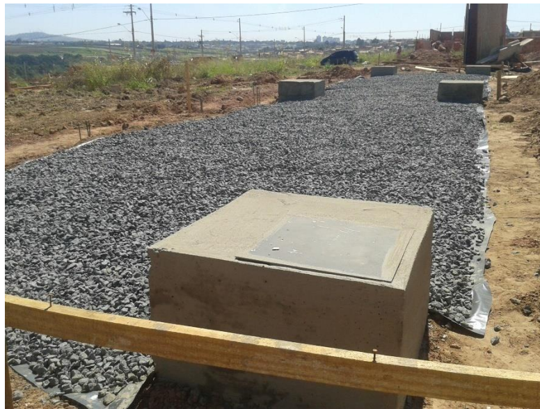
Figura 9: Terreno coberto com manta impermeável e brita.
