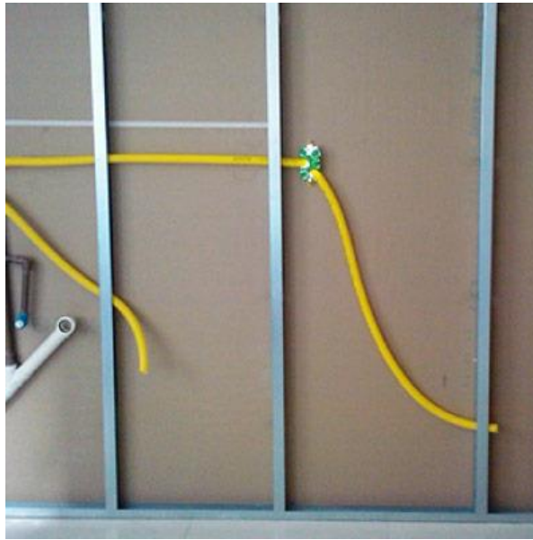
Figura 23: Forro em Drywall estruturado
