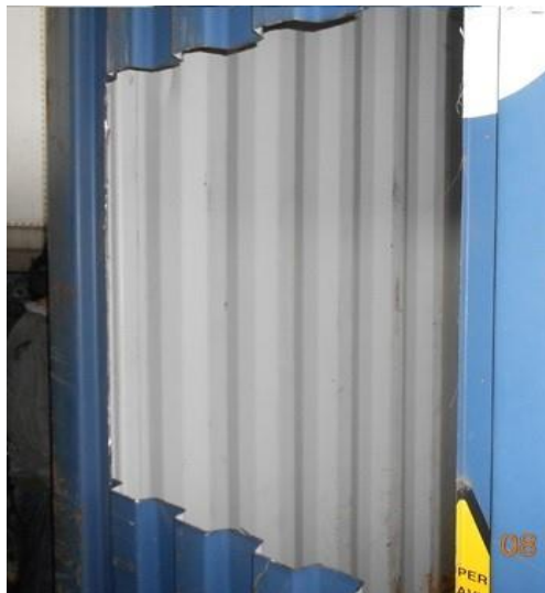
Figura 19: Corte para instalação de uma janela
