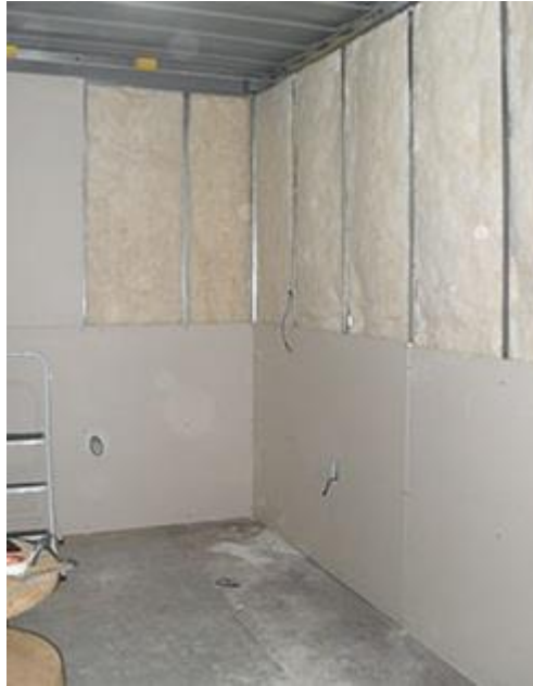
Figura 16: Revestimento de parede em Drywall
