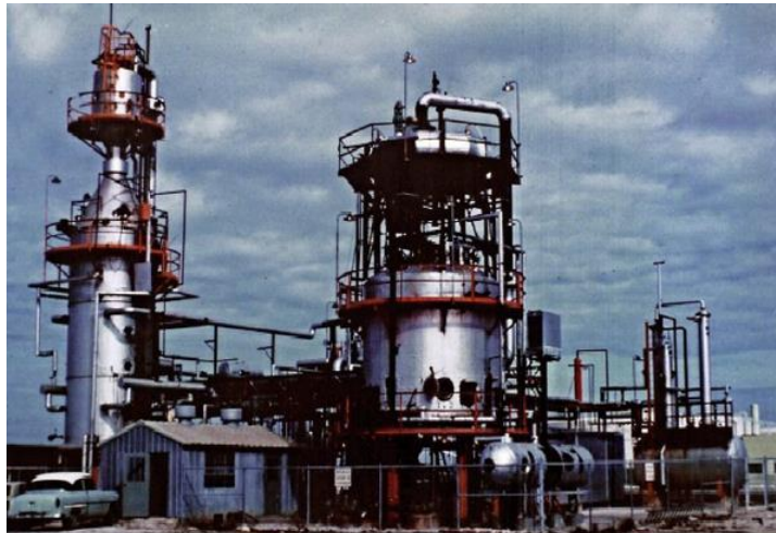
Figura 16 - Dessalinizador por congelamento. (Fonte: Delyannis e Belessiotis (2010)).
