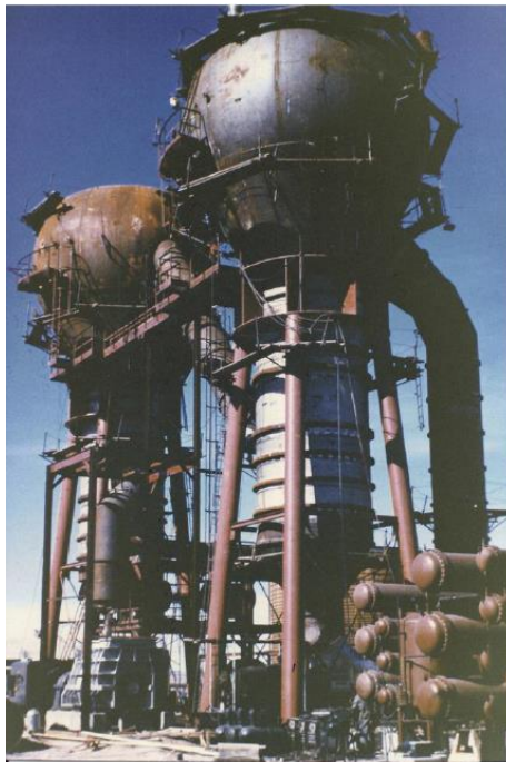
Figura 13 - Destilador VC. (Fonte: E. Delyannis, V. Belessiotis (2010))
