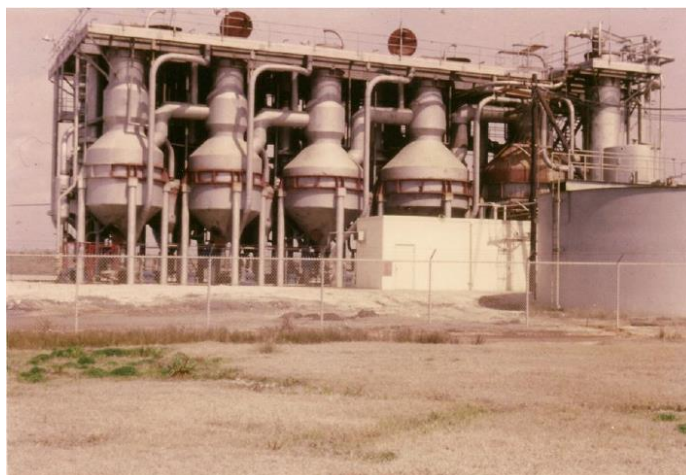
Figura 11 - Destilador MED. (Fonte: Delyannis e Belessiotis (2010))
