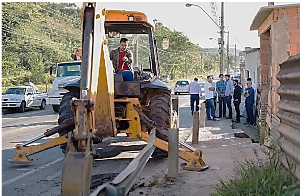
Fotografia 3 - Obra da rede de distribuição
