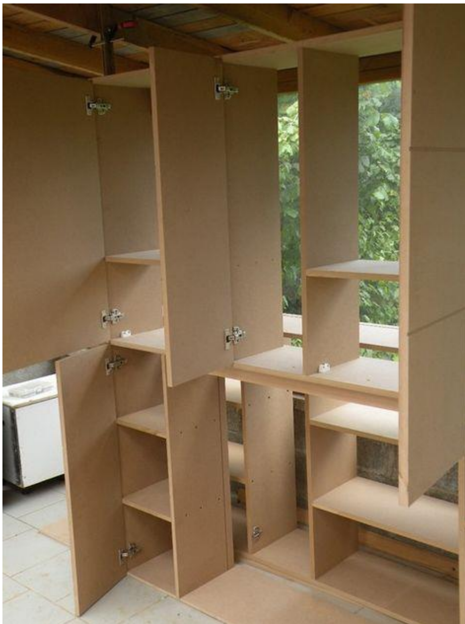
Figura 20: Construção de MDF.
