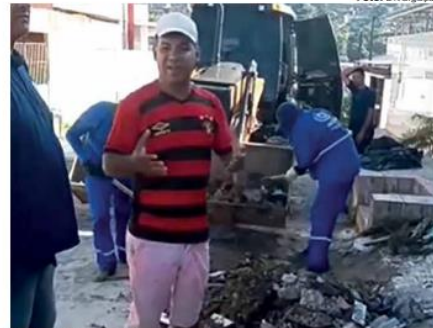
EM LOCO Jairo Kaito acompanha serviço de limpeza no bairro
