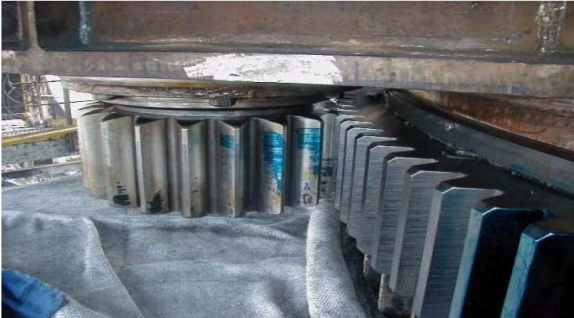
Figura 24: Acionamento do rolamento central do Stack-Reclaimer.
