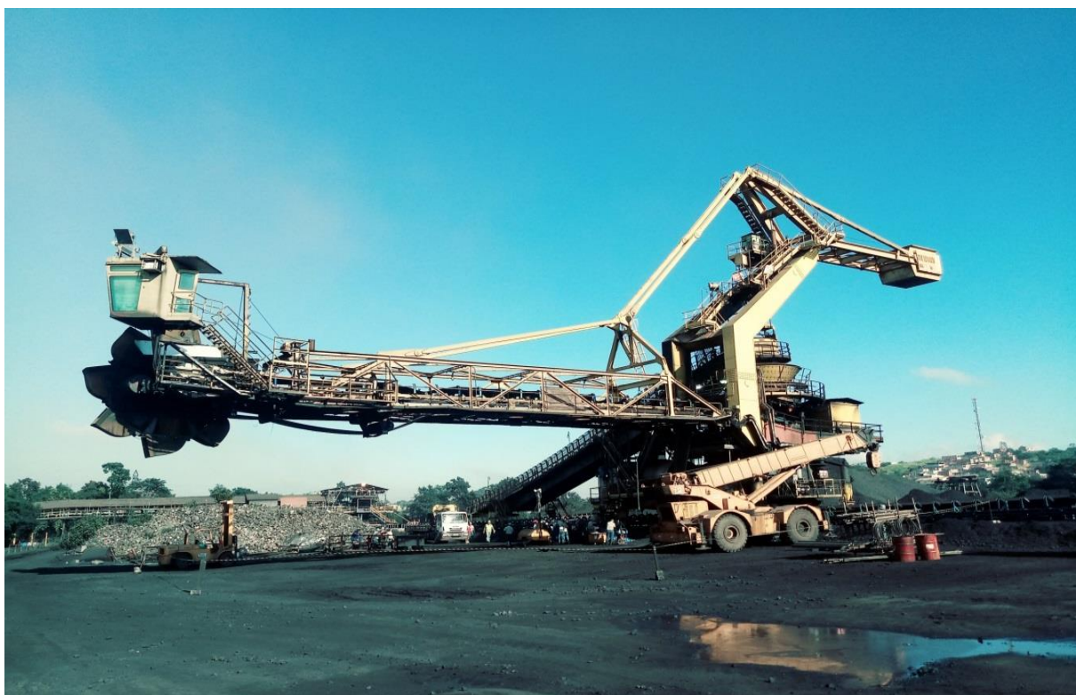
Figura 21: Manutenção do Stacker-Reclaimer.
