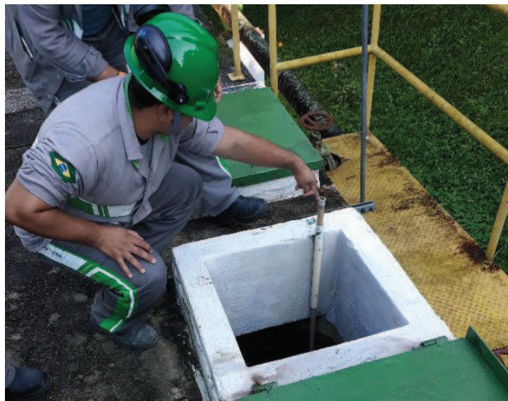
Figura 17 - Operador Verificando nível do reservatório [11]
