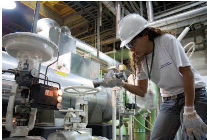
Figura 12 - Inspeção de Segurança [9]
