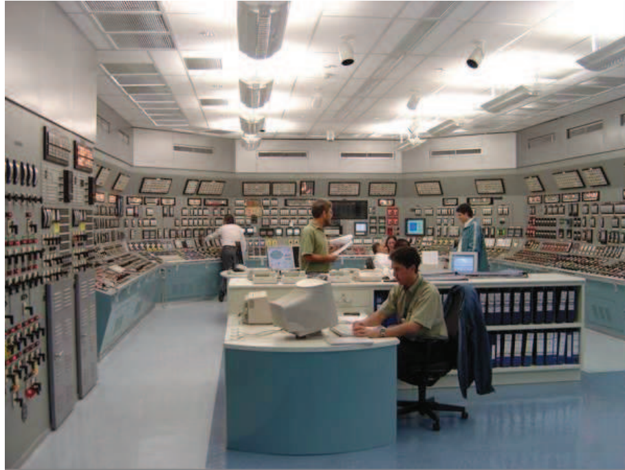
Figura 13 - Sala de Controle [9]
