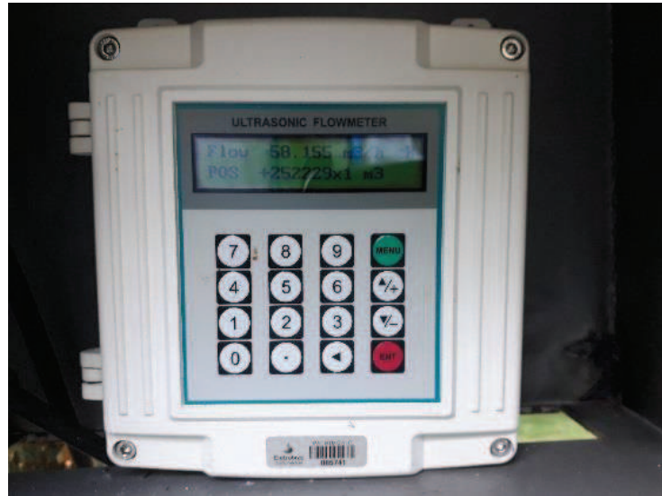
Figura 20 - Medidor de Fluxo Ultrassônico de Saída [11]
