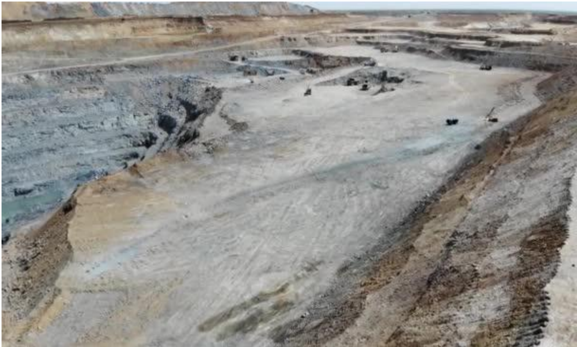
Figura 7 - Escavação de minério de ferro industrial (Fonte: adaptado de br.depositphotos.com)
