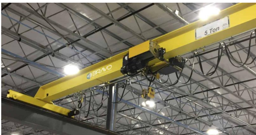
Figura 6. Ponte Rolante Com Viga I
