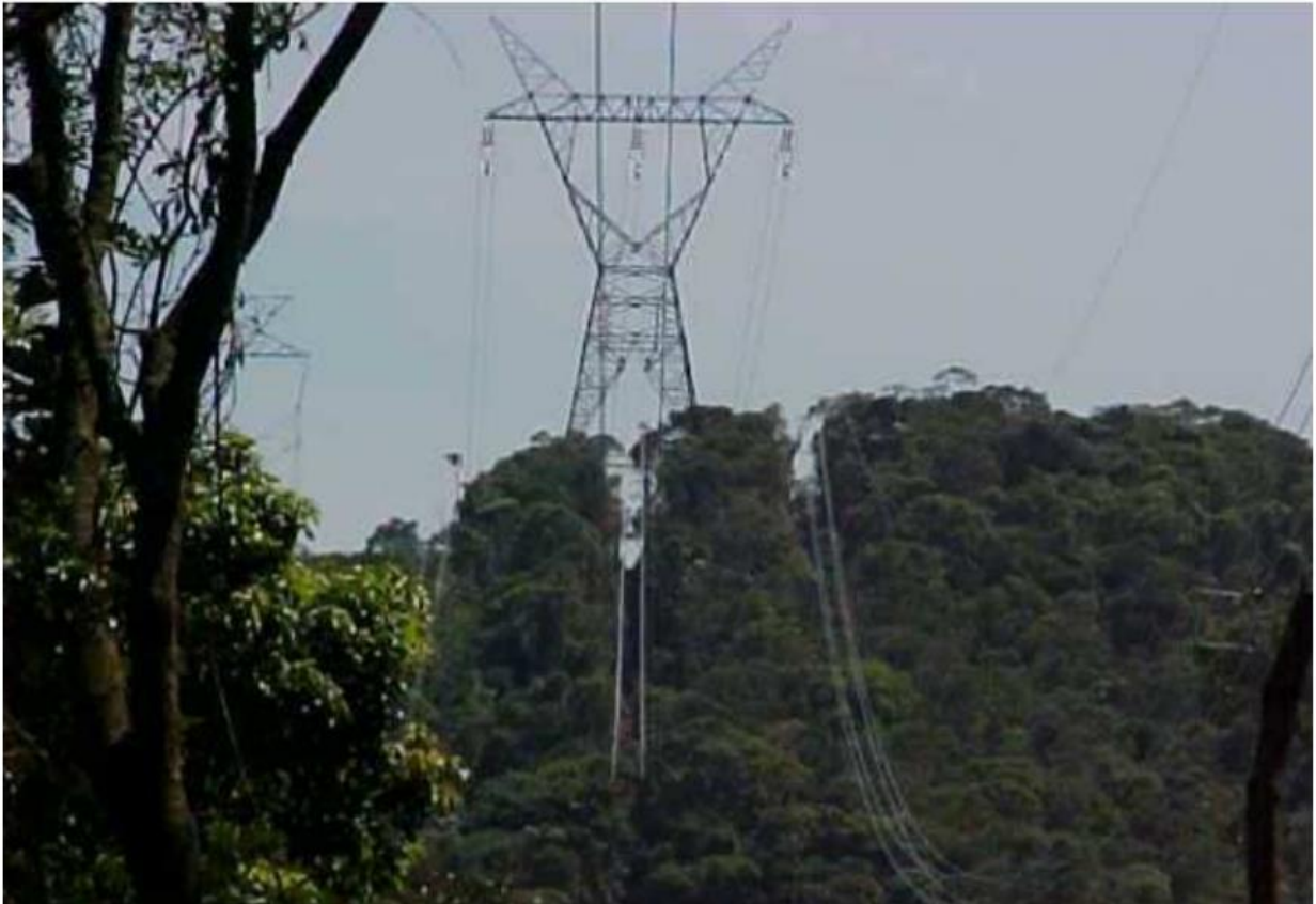
Figura 16: Corte de vegetação realizado apenas onde os cabos de energia são lançados. Fonte: YUHARA, 2015
