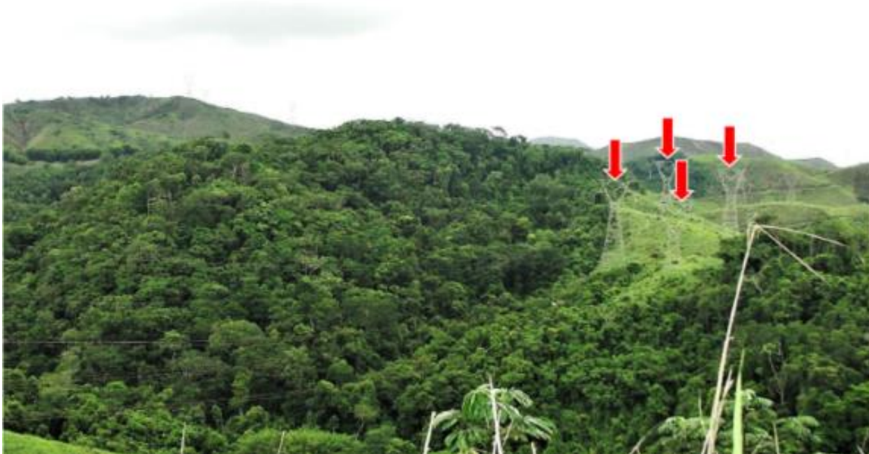
Figura 2: Localização das 04 torres das Linhas de Transmissão de 500KV Cachoeira Paulista - Adrianópolis I e II no interior da ARIE Floresta da Cicuta.
