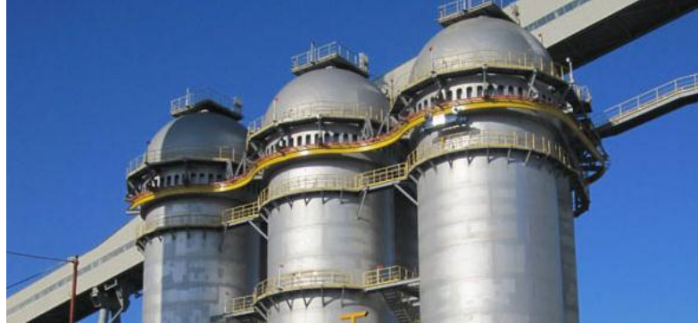
Figura 11: Regeneradores de alto forno
