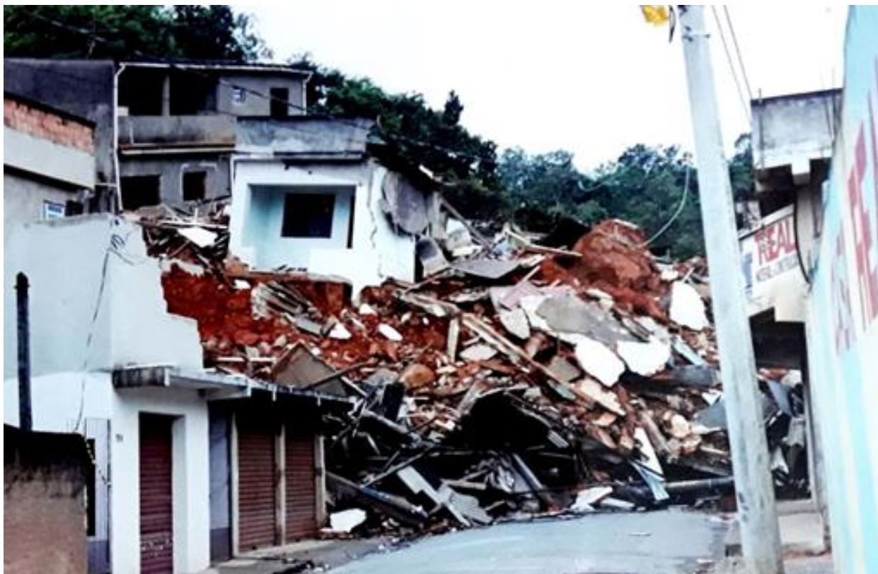
Figura 17 - Escombros das casas atingidas bloqueando a Rua B. Fonte: Arquivo pessoal do orientador (1999).
