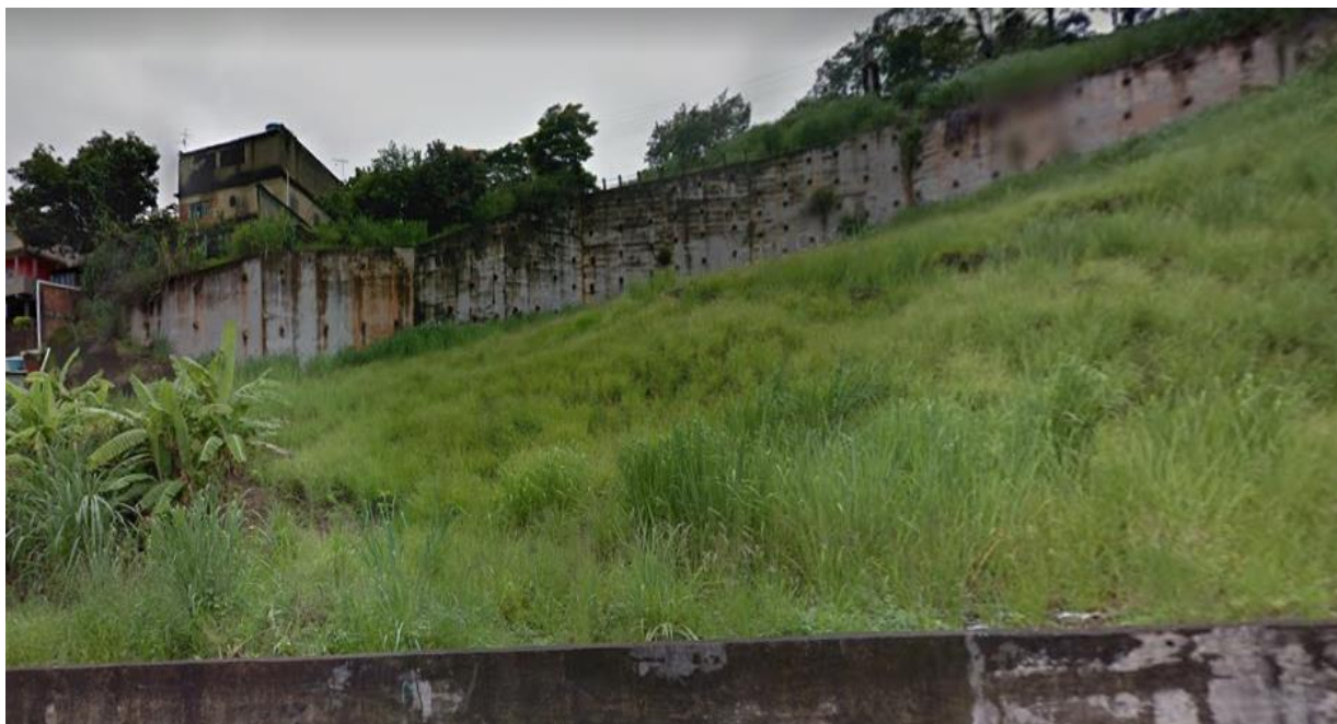
Figura 21 - Cortina atirantada executada como contenção no local. Fonte: Adaptado de Google Maps (2019).
