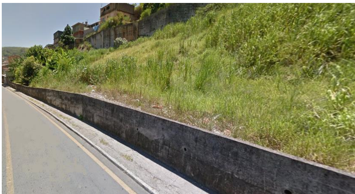
Figura 22 - Contenção na parte inferior do talude. Fonte: Adaptado de Google Maps (2019).
