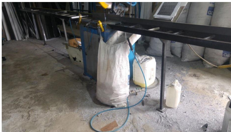
Figura 15: Implantação de coletor de resíduos de usinagem
