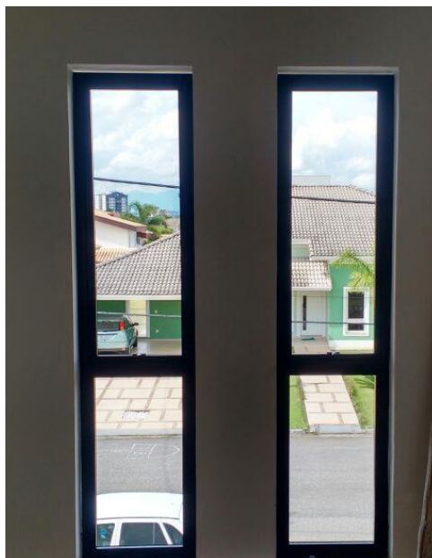
Figura 1: Esquadria de Alumínio instalada pela Alumi'Integra
