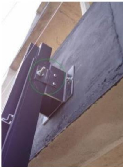
Figura 7 - Ancoragem do montante à supra estrutura do edifício (Fonte: SANTOS, 2013)
