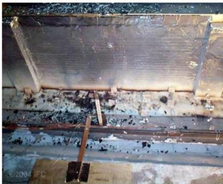
Figura 30 – Superfície não exposta da barreira periférica contra fogo após o término do ensaio (Fonte: TOMA, 2012)
