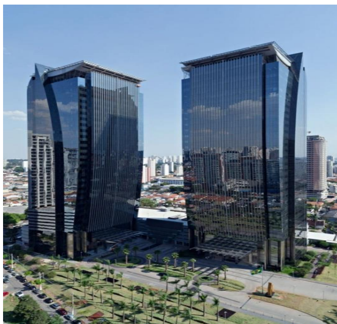
Figura 2 - O edifício EZ Towers, concluído em 2015, possui grandiosos 54.700m 2 com vidros laminados refletivos.
