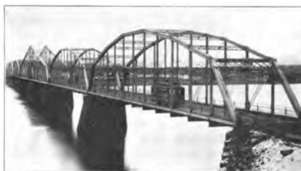
Figura 7: Ponte cruzando o Rio Connecticut
