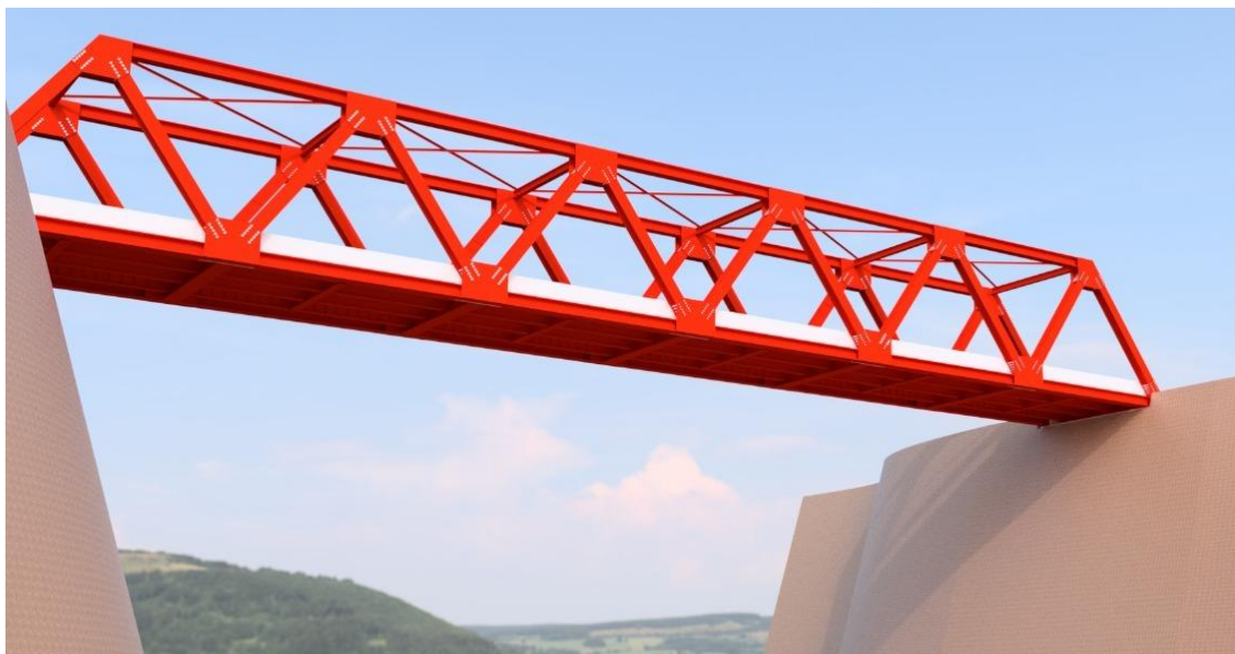
Figura 48 - Vista da Ponte Treliçada em vão de 90m
