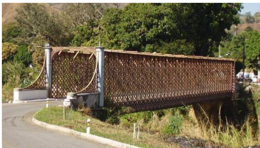
Figura 8: Ponte Alberto Torres
