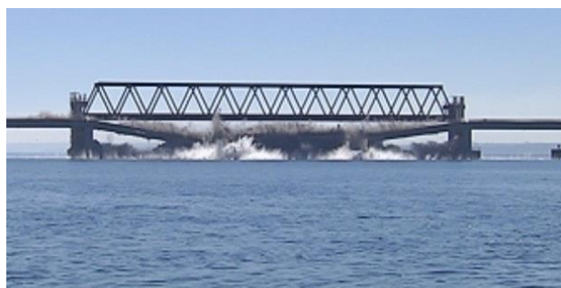
Figura 12: Implosão Ponte Rio Pongá
