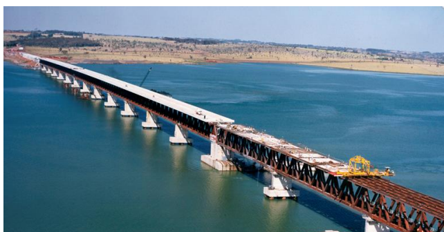
Figura 13: Ponte rodoferroviária Paraná
