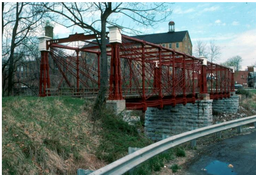
Figura 3: Ponte treliçada do tipo Bollman em Savage, Maryland
