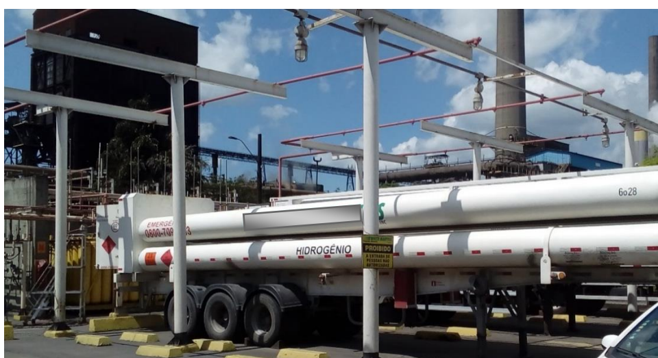
Figura 24 - Estruturas existentes utilizadas no projeto de sustentação das mangueiras de enchimento
