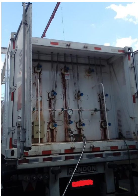
Figura 15 - Compartimento traseiro para carregamento das carretas
