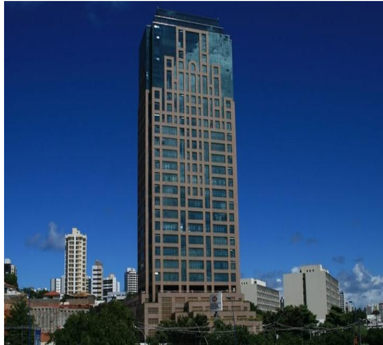
Figura 4: Edifício Suarez Trade Center
