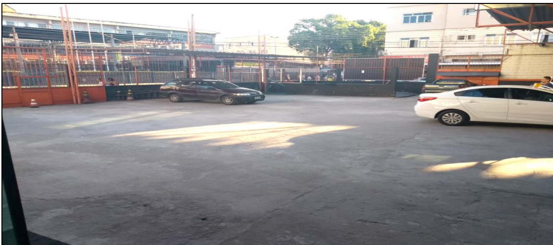
Fotografia 13: Espaço com o Novo Piso
