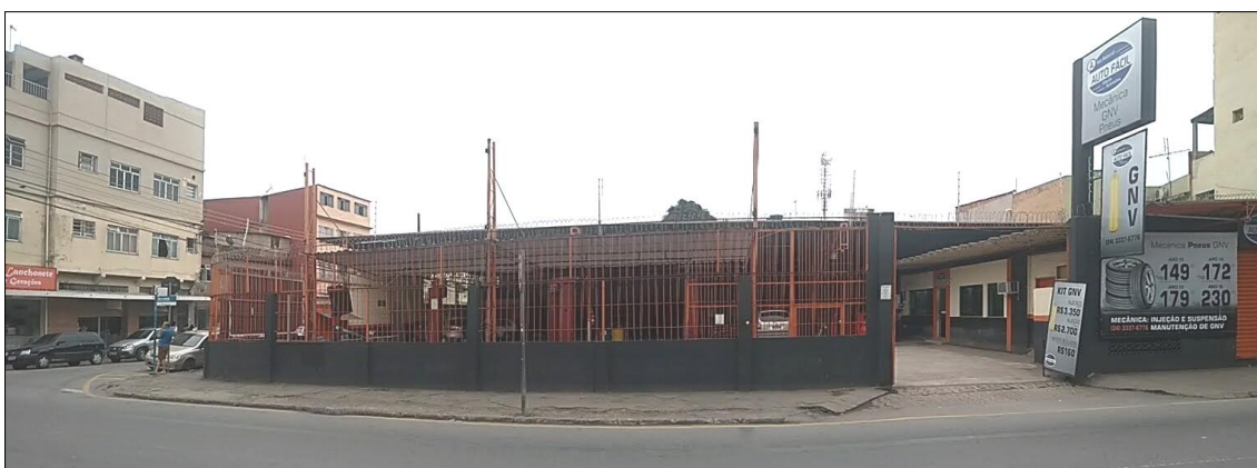
Fotografia 1: Fachada da Oficina. Fonte: As Autoras.
