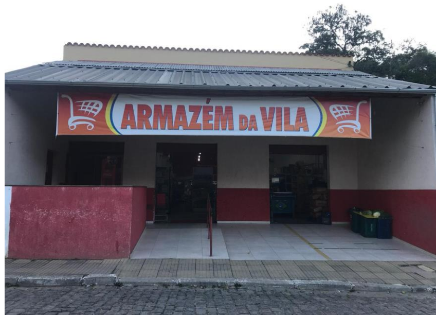
Figura 5: Fachada do Supermercado Armazém da Vila.
