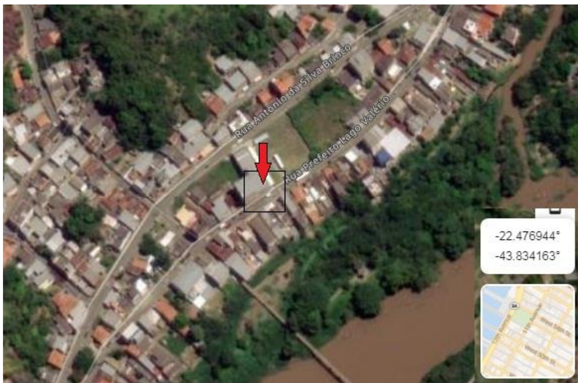
Figura 23 – Visão registrada por satélite e coordenadas Fonte: Google Earth
