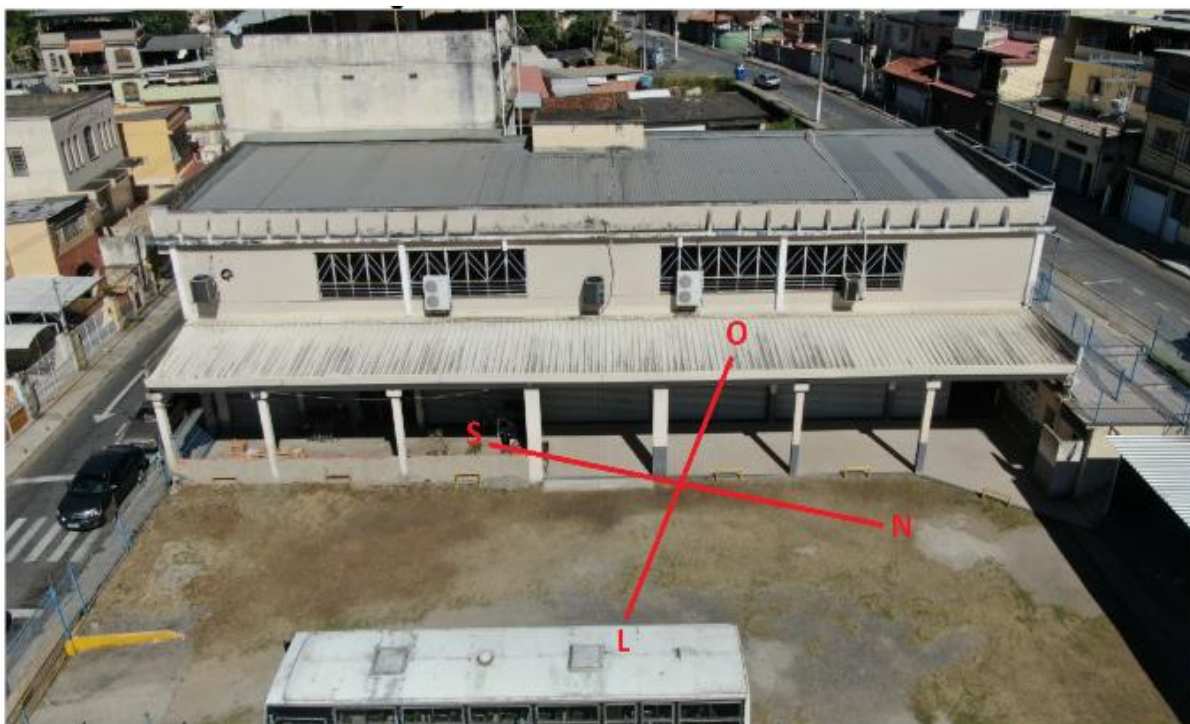
Figura 24 – Vista panorâmica do telhado do edifício Fonte: O Autor
