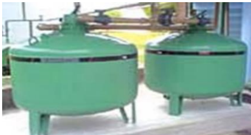
Figura 16 - Filtros de Zeólita 2-200m 3 /h.
