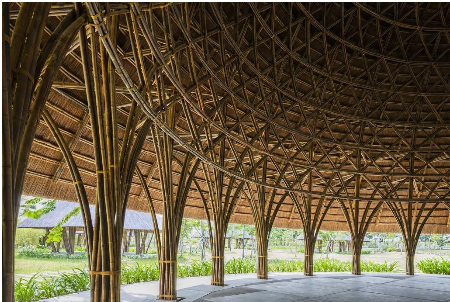
Figura 74: Estrutura em bambu
