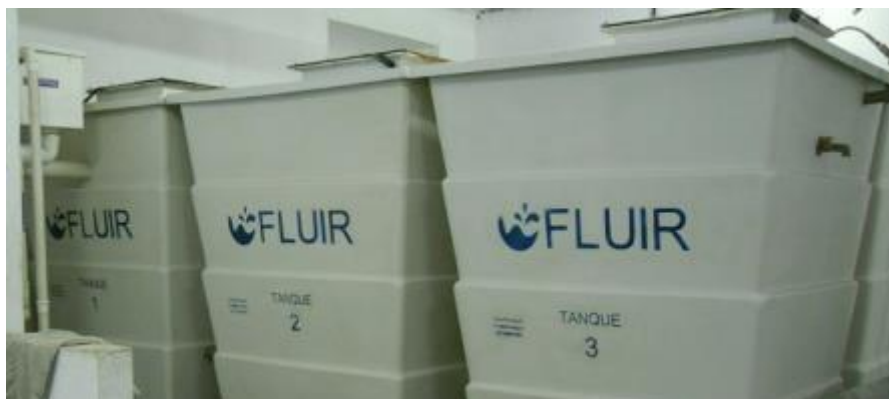
Figura 8. Reator anaeróbio compartimentado.
