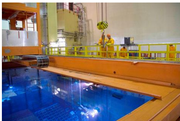
Figura 11 - Piscina Destinada à Rejeitos de Alta Atividade em Angra 2 Fonte: Eletronuclear (2020)
