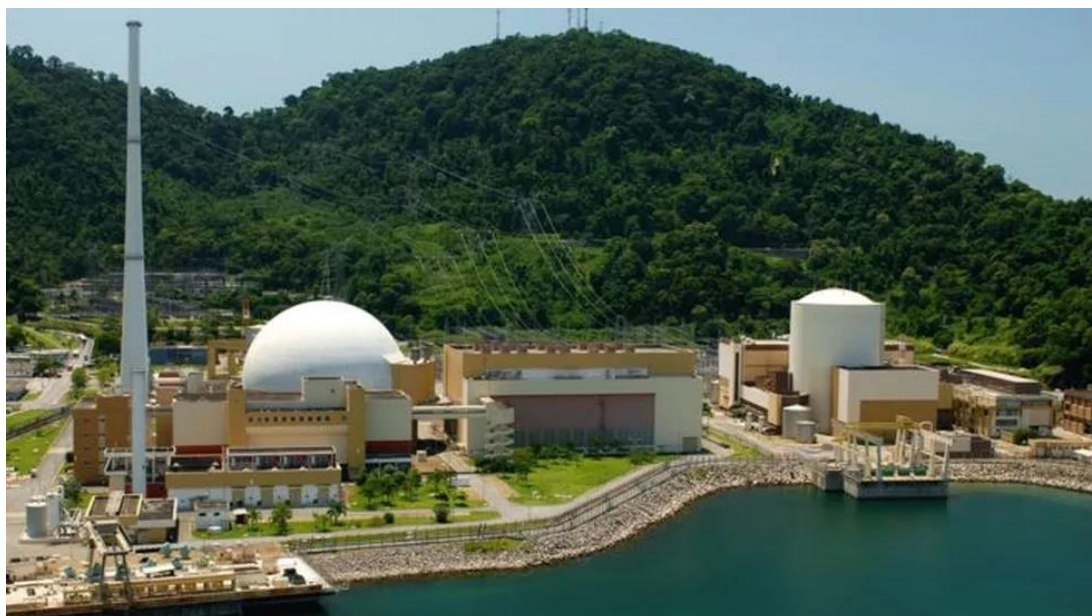
Figura 6 - Usinas Angra 2 (à esquerda) e Angra 1 (à direita); os reatores, onde a energia nuclear é gerada, ficam dentro das estruturas brancas.
