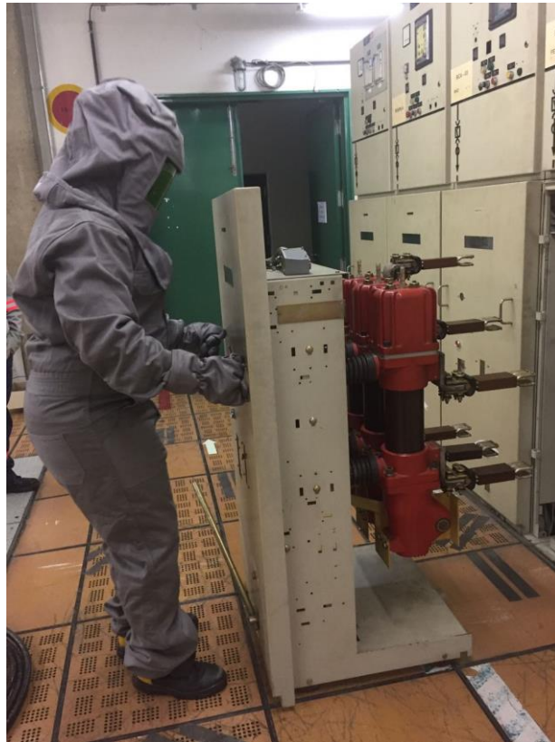
Figura 17 - Roupas de proteção térmicas Fonte: Acervo Professor Cláudio Márcio de Freitas da Silva
