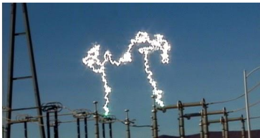
Figura 10 - Ocorrência de um arco elétrico controlado Fonte: SENAI - 2011
