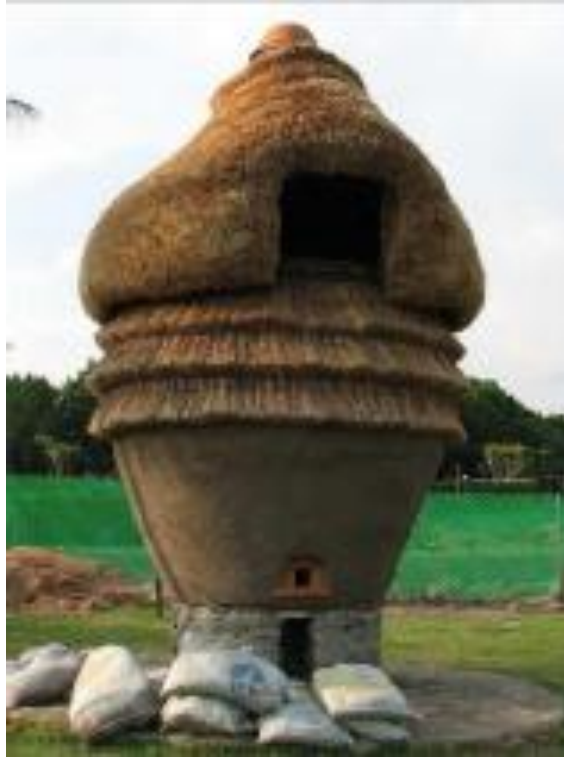
Figura 9 - Exemplo de moradia construída a partir do método construtivo em Terra Modelada. Celeiro em Cuernavaca, localizado no México
