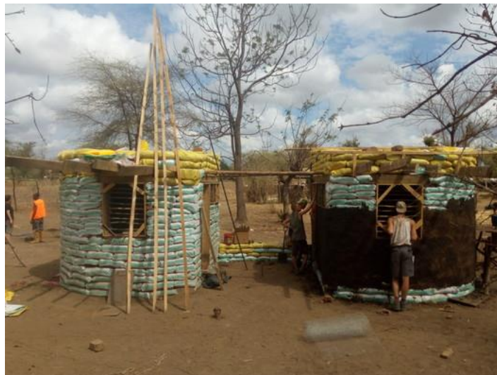
Figura 33 – Processo de construção por meio de Terra Ensacada
