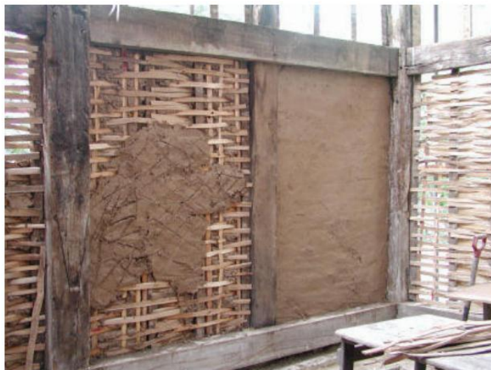
Figura 23 – Processo de edificação utilizando a técnica de terra sobre engradado.
