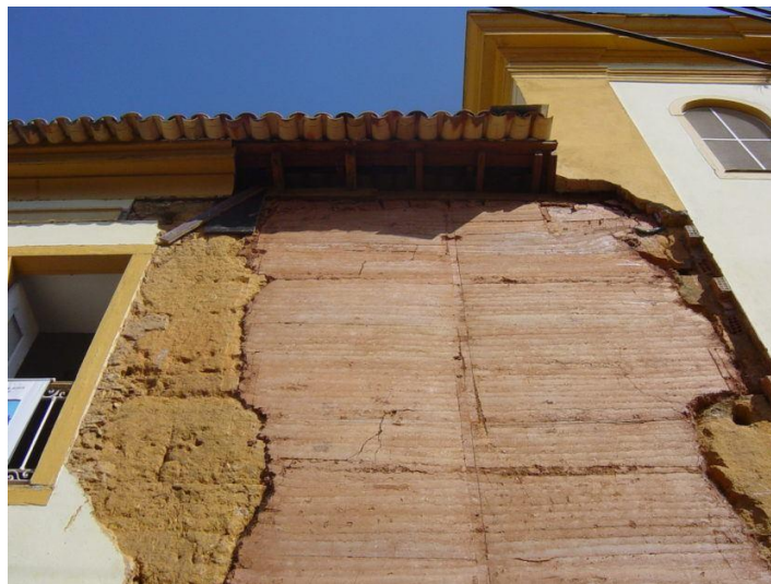
Figura 42 - Camadas de apiloamento aparentes após secagem.
