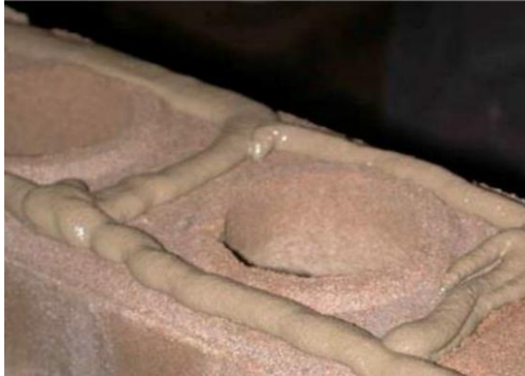
Figura 25 – Aplicação de argamassa com utilização de bisnaga.
