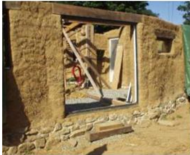
Figura 20 – Exemplo de edificação pela técnica de Terra-palha.
