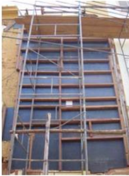
Figura 41 - Estrutura de madeira para apiloamento da mistura.
