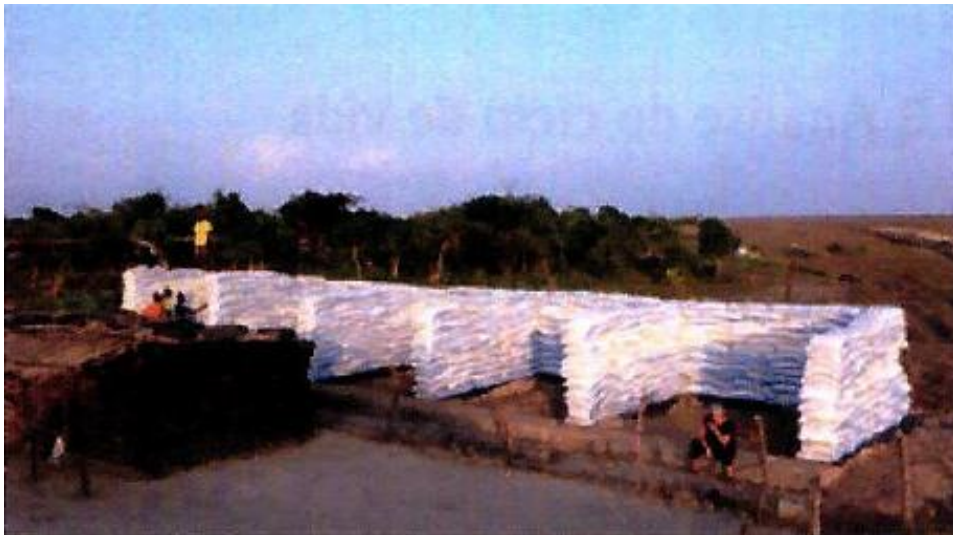
Figura 19 – Fase final de colocação de sacos.
