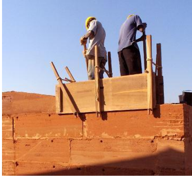
Figura 12 – Processo de apiloamento de parede construída em taipa de pilão.
