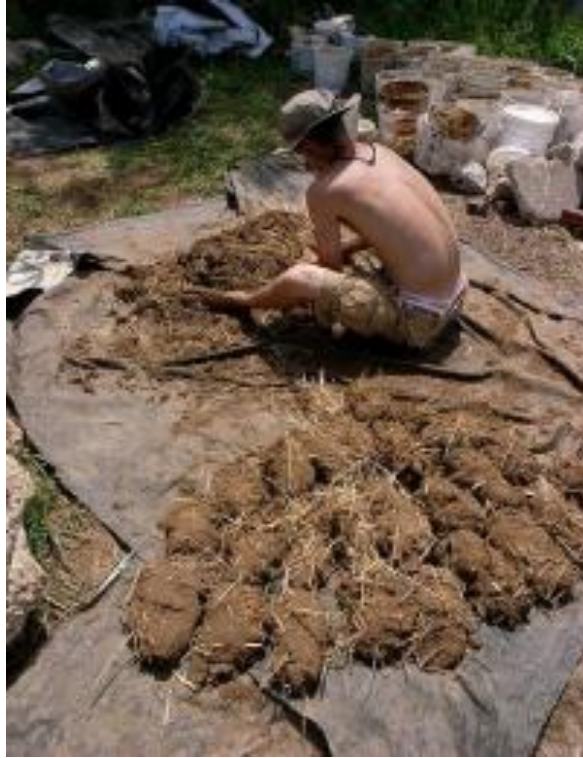
Figura 7 - Exemplo de argamassa utilizada no sistema construtivo Terra Empilhada
