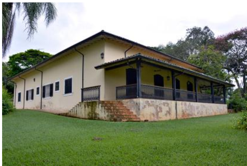
Figura 13 - Casa bandeirista de Taperão construída em Taipa de Pilão
