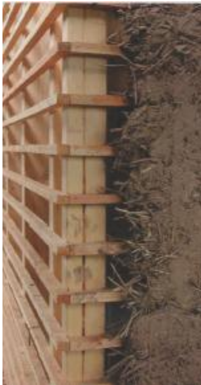
Figura 29 - Detalhe da estrutura em painel de madeira pré-fabricada
