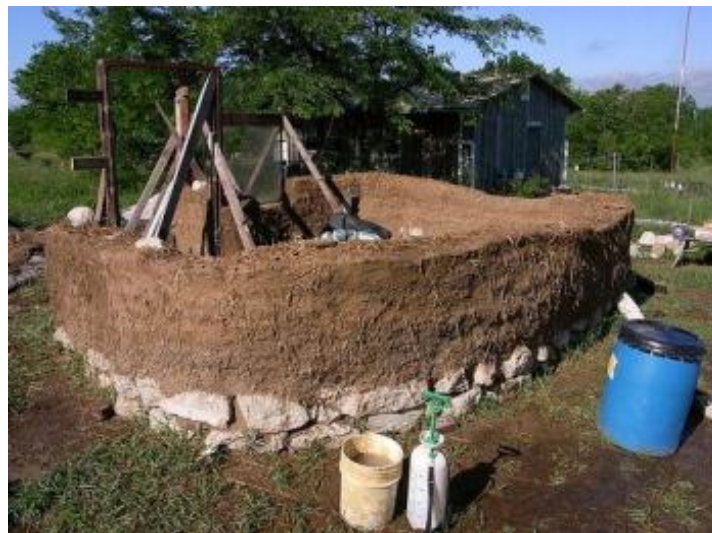
Figura 8 - Parede sendo construída a partir do método de Terra Empilhada
