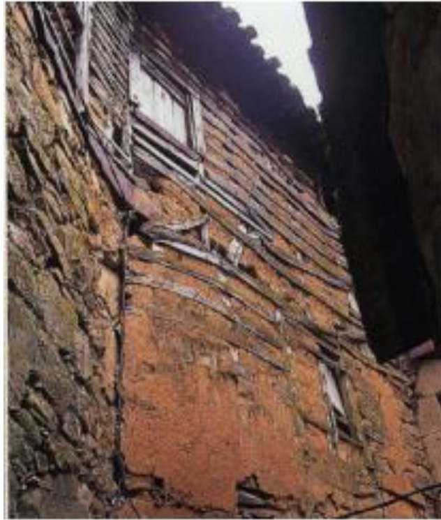
Figura 24 – Edificação em terra sobre engradado.
