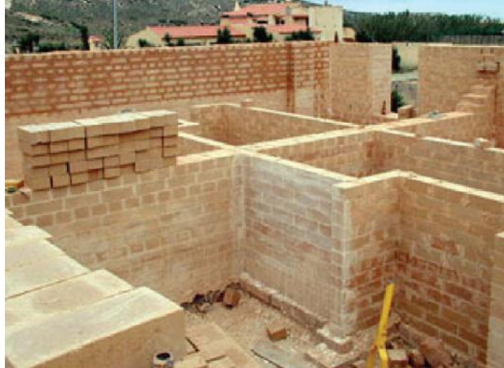
Figura 17 – Construção de alvenaria com recurso a BTC.
