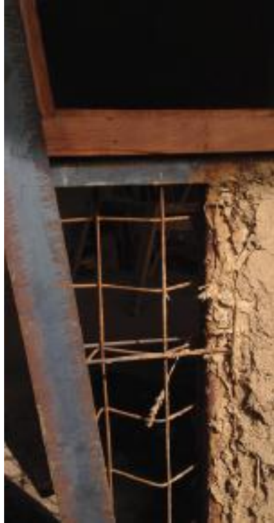
Figura 28 - Detalhe de painel metálico substituindo as tramas de madeira
