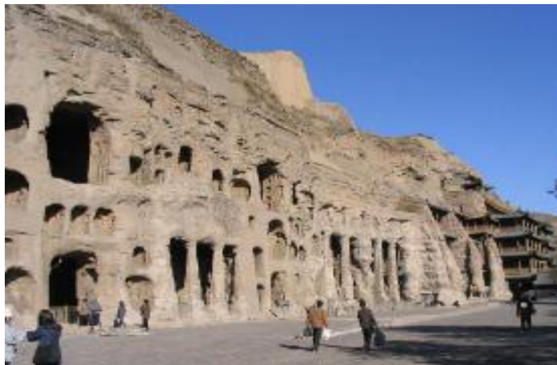
Figura 4 - Terra Escavada na horizontal
