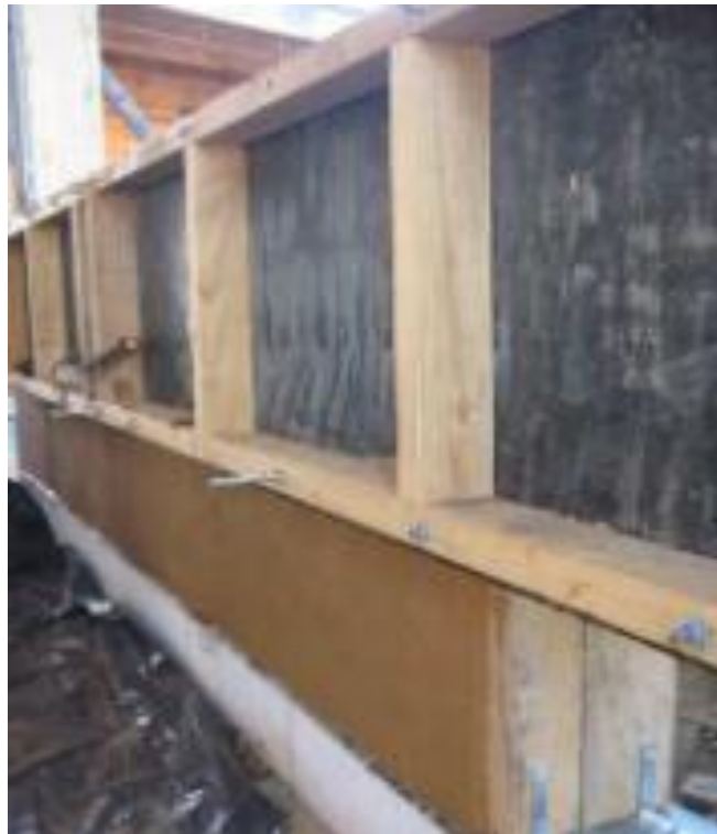
Figura 6 - Parede sendo construída a partir do método Terra Plástica
