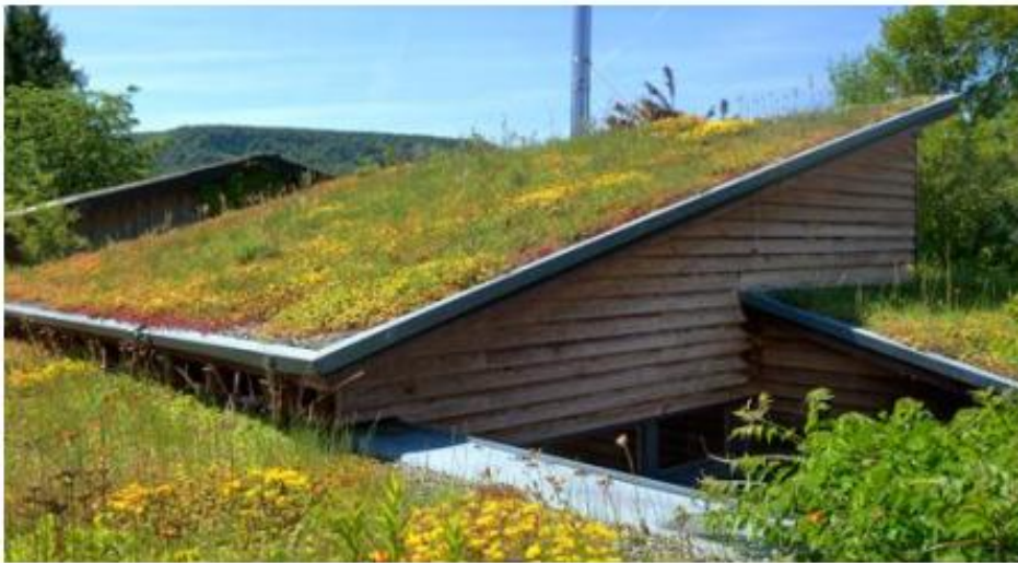
Figura 22 – Edifício com cobertura em terra.
