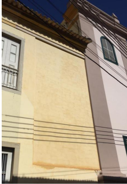
Figura 43 - Parede finalizada com emboço de terra.
