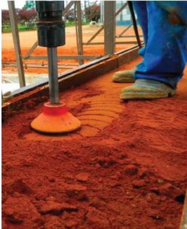
Figura 31 - Compactação da terra com pilão pneumático executada por empresa brasileira Taipal
