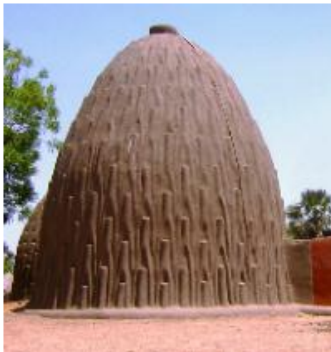
Figura 10 - Exemplo de moradia construída a partir do método em terra moldada. Cabana Mousgoum localizada em Camarões.
