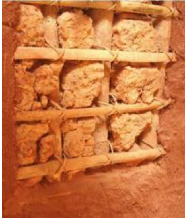
Figura 11 – Detalhes de parede construída em taipa de mão.
