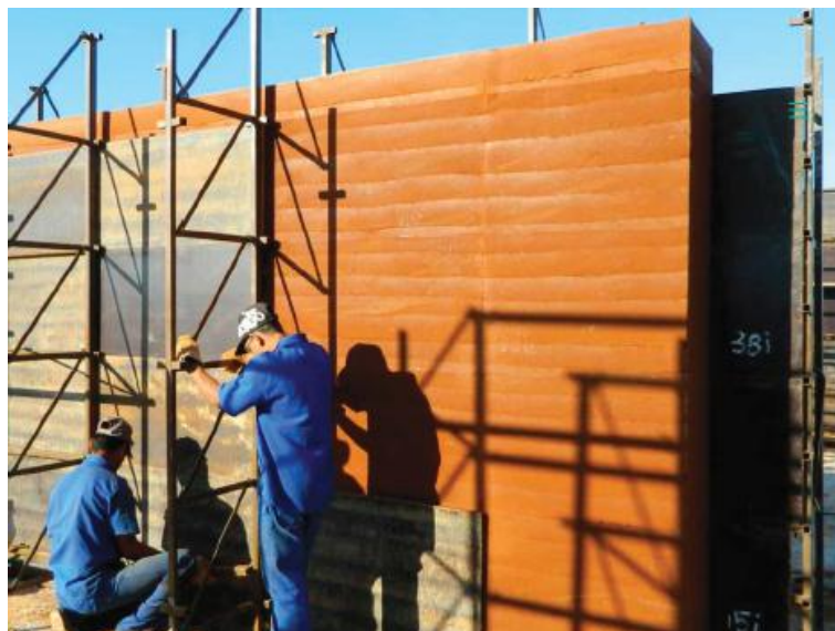
Figura 32 – Fôrmas metálicas sendo utilizadas na prática pela empresa brasileira Taipal.
