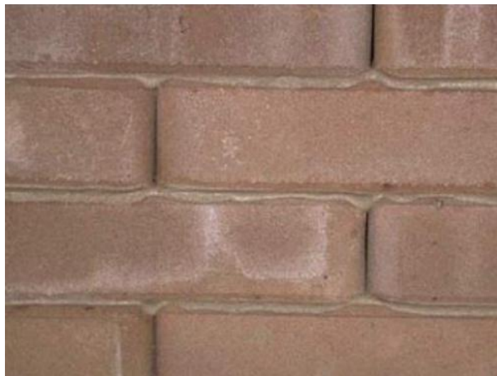
Figura 26 – Detalhe da espessura das juntas.
