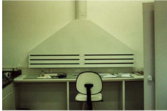
Figura 6: Captor tipo fenda frontal para exaustão de fumos/gases
