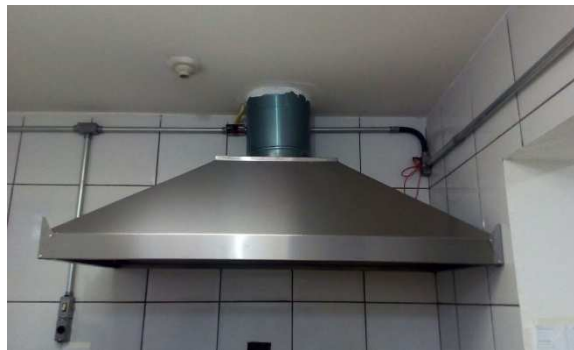
Figura 5: Coifa em inox para exaustão de fumos/gases
