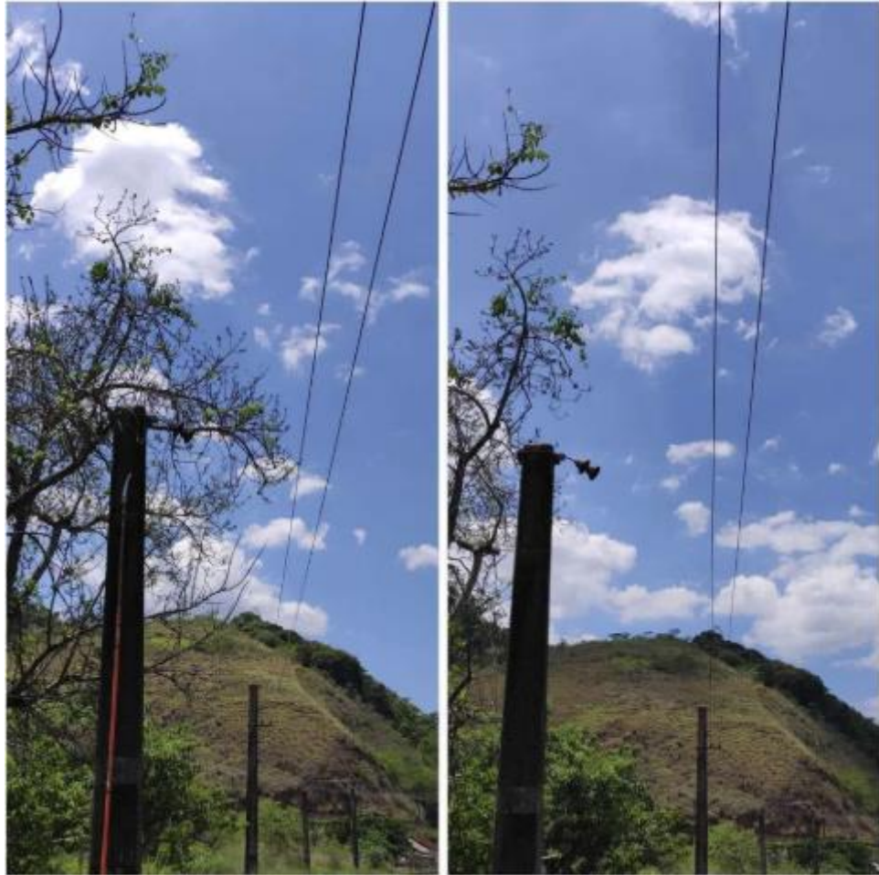
Figura 9 – Alimentadores bifásicos Fonte: (Própria, 2020)
