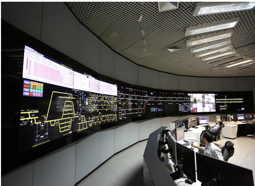
Figura 25 – CCO com controladores em atividade Fonte: (Própria, 2020)
