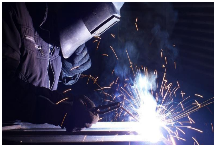
Figura 1 - Alusão a Processo Atual de Soldagem
