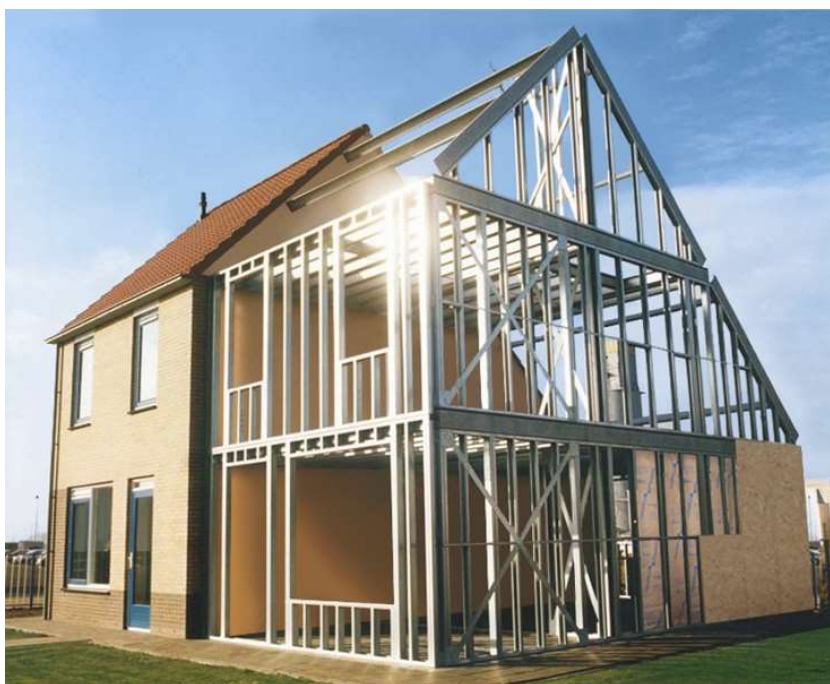
Figura 3 – Construção em Light Steel Framing Fonte: Rio Steel, 2019
