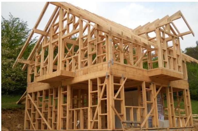
Figura 2 – Método construtivo Wood Framing Fonte: ABIMCI, 2016
