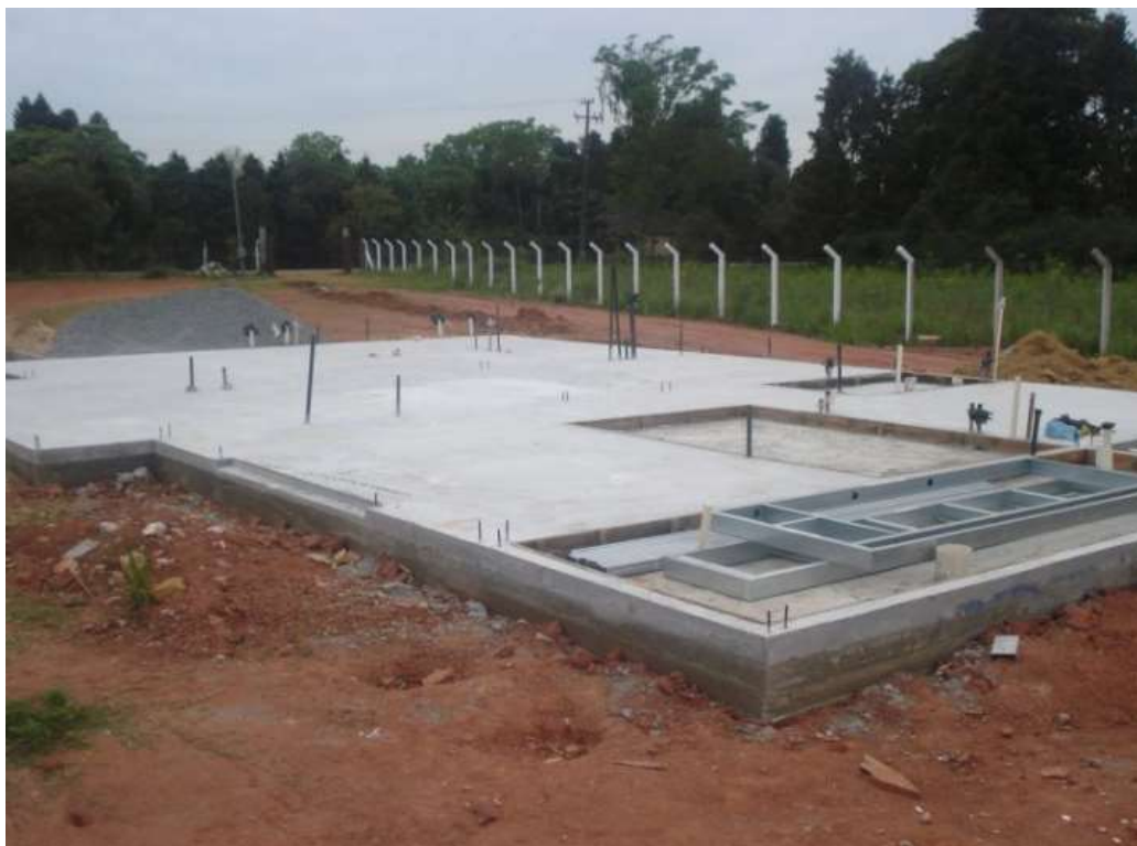
Figura 16 – Fundação em Radier Fonte: ConstruindoDecor, 2020
