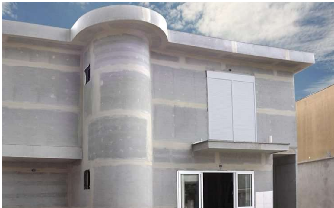
Figura 20 – Placas cimentícias em área externa Fonte: Ancôra, 2017
