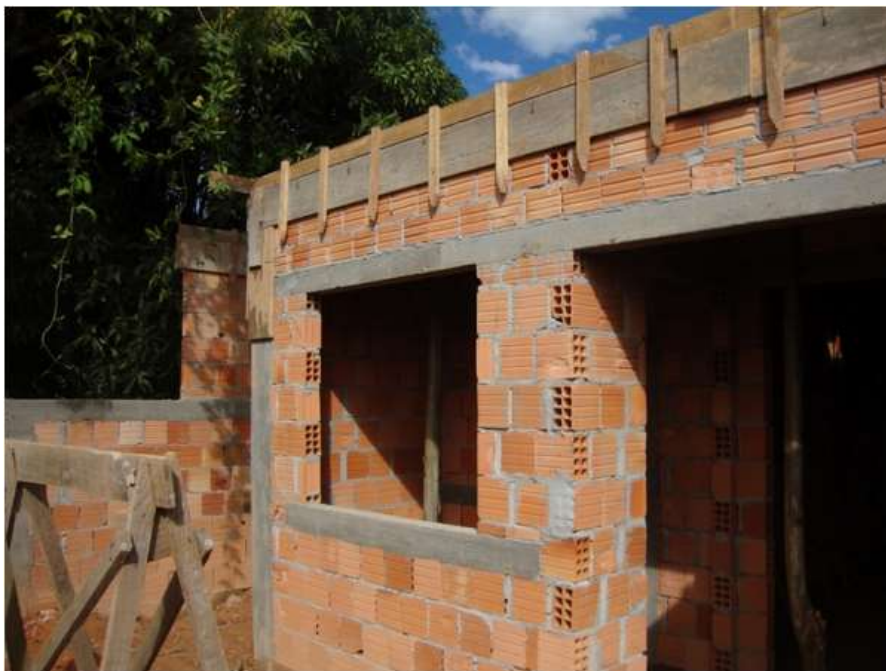
Figura 13 – Exemplo de Verga e Contraverga Fonte: Dryplan, 2016
