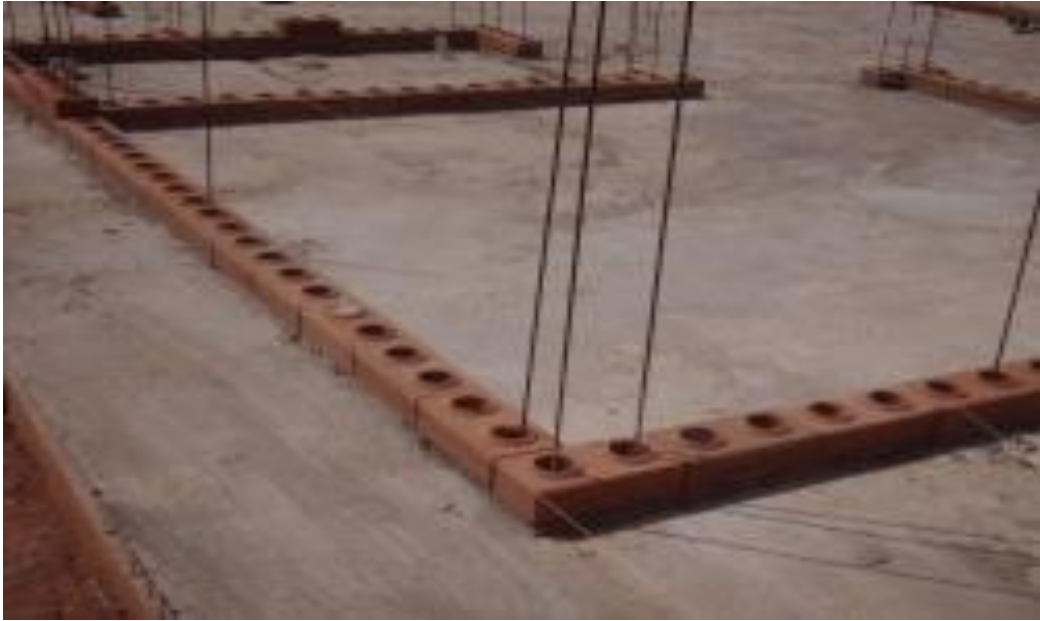
Figura 7 - Primeira fiada de tijolos Fonte: Tijoleko (2011).
