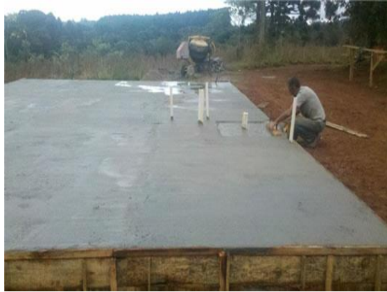
Figura 4 - Fundação tipo radier concretada Fonte: Eco Maquinas (2016).
