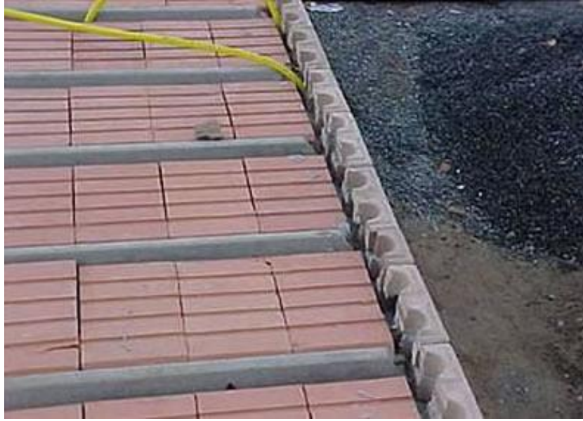
Figura 18 - Laje com Lajota Fonte: Monte seu Projeto (2011).
