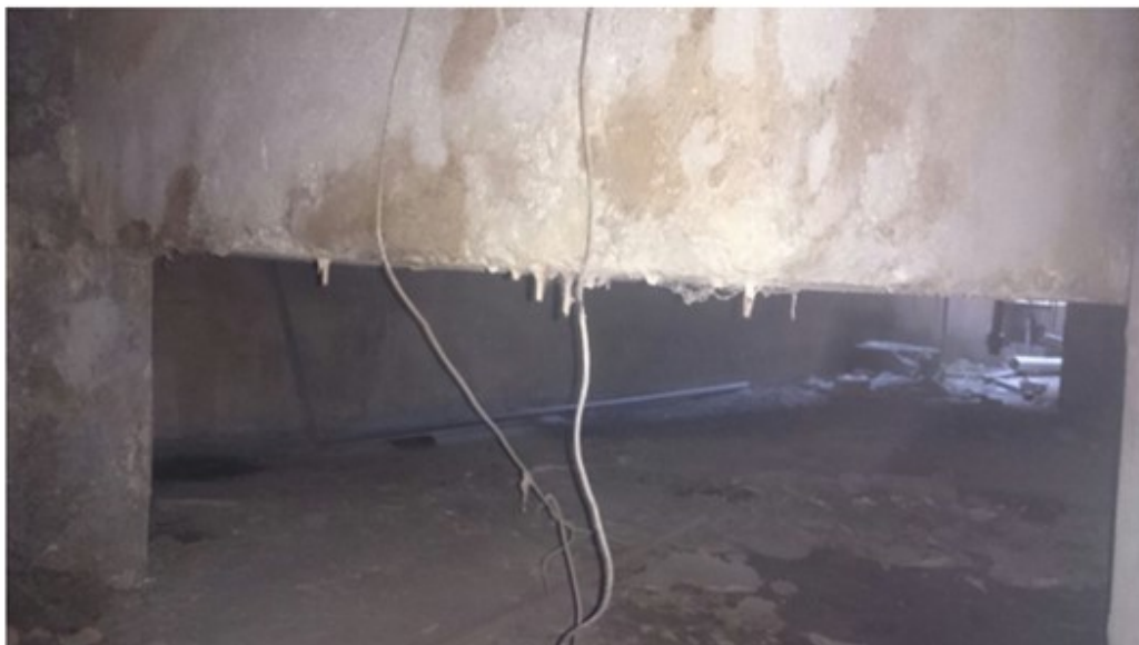
Figura 10 - Processo de lixiviação em vida de concreto armado.
