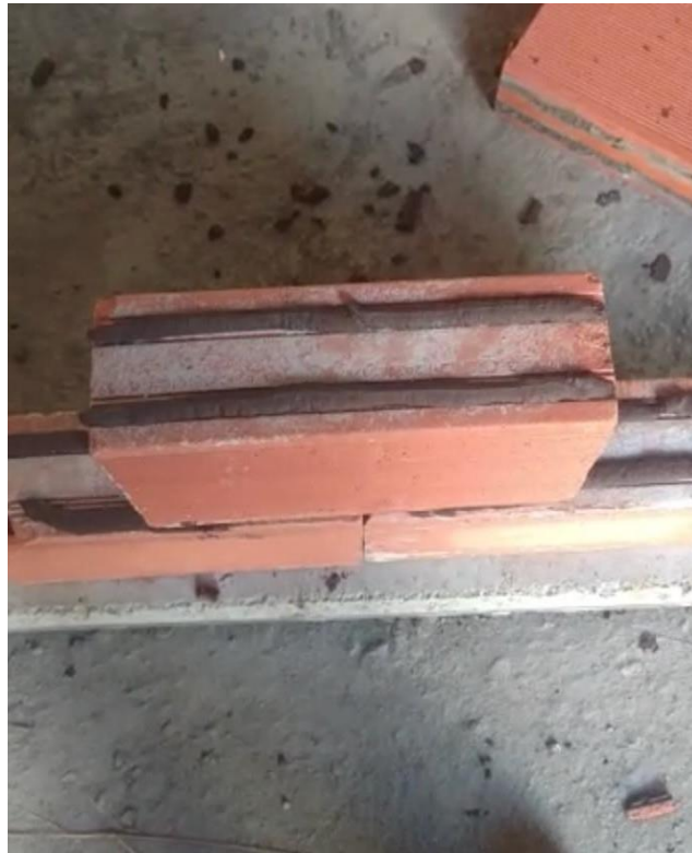
Figura 5: Argamassa polimérica aplicada na alvenaria
