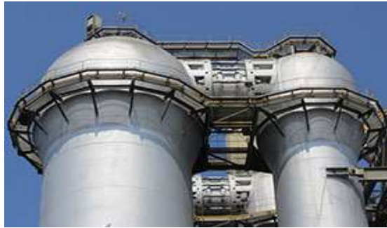
Figura 10: Regeneradores de alto forno.
