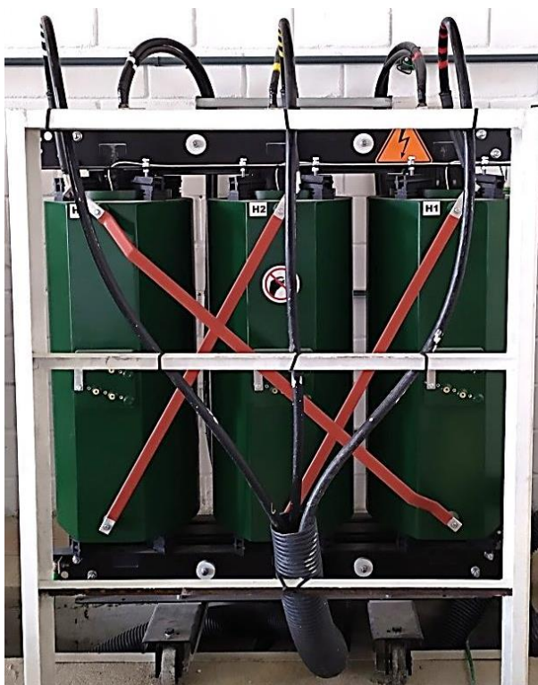
Figura 33 - Transformador 750 KVA
