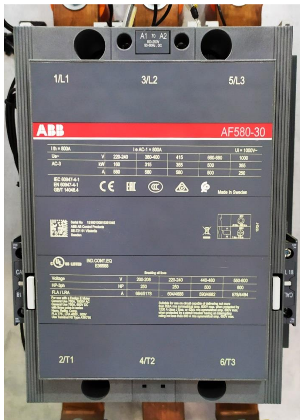
Figura 31 - Disjuntor AF580-30 Fonte: Autores (2020).
