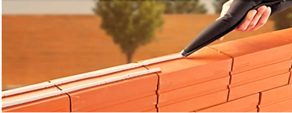
Figura 1 - Aplicação da argamassa polimérica em blocos
