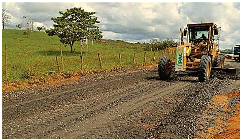
Figura 2 - Emprego da escória na pavimentação
