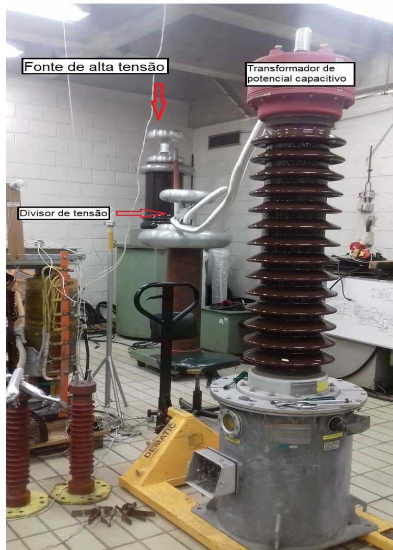
Figura 32– Arranjo de ensaio de ferro-ressonância em TPC
