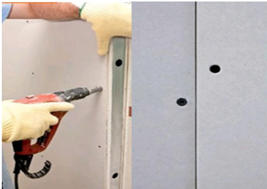
Figura 59: Instalação das placas de gesso nos perfis de alumínio.
