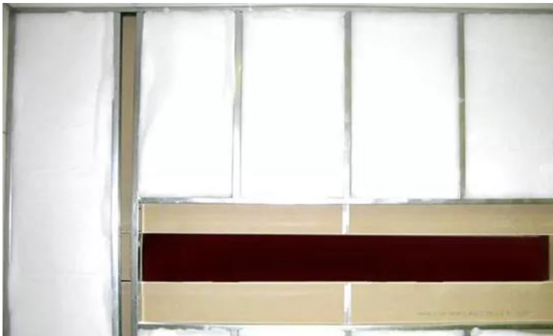
Figura 24: Lã de pet instalada na parede
