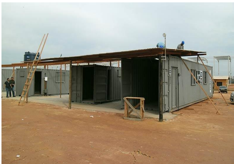
Figura 19: Instalação de canteiro de obras utilizando containers.
