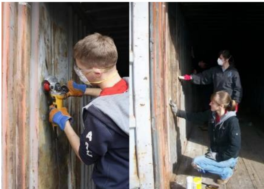
Figura 45: Limpeza mecânica e manual da parede do container.
