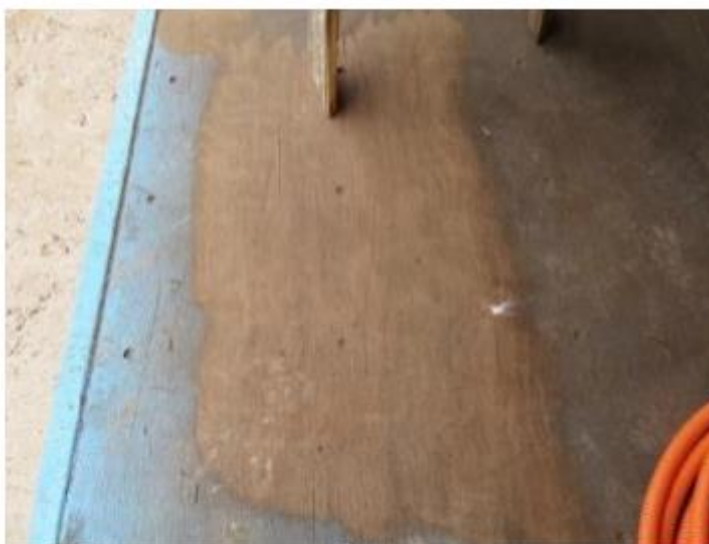
Figura 28: Piso de compensado naval em containers
