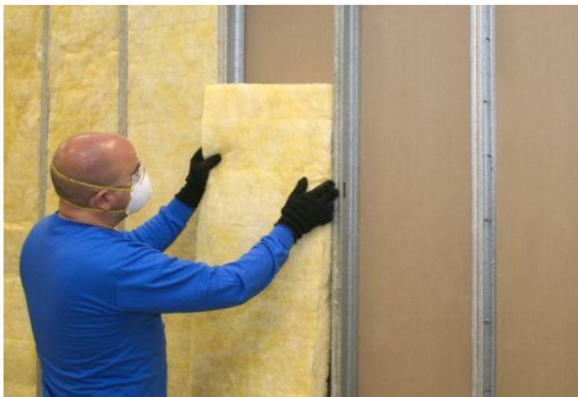
Figura 22: Instalação de lã de vidro.
