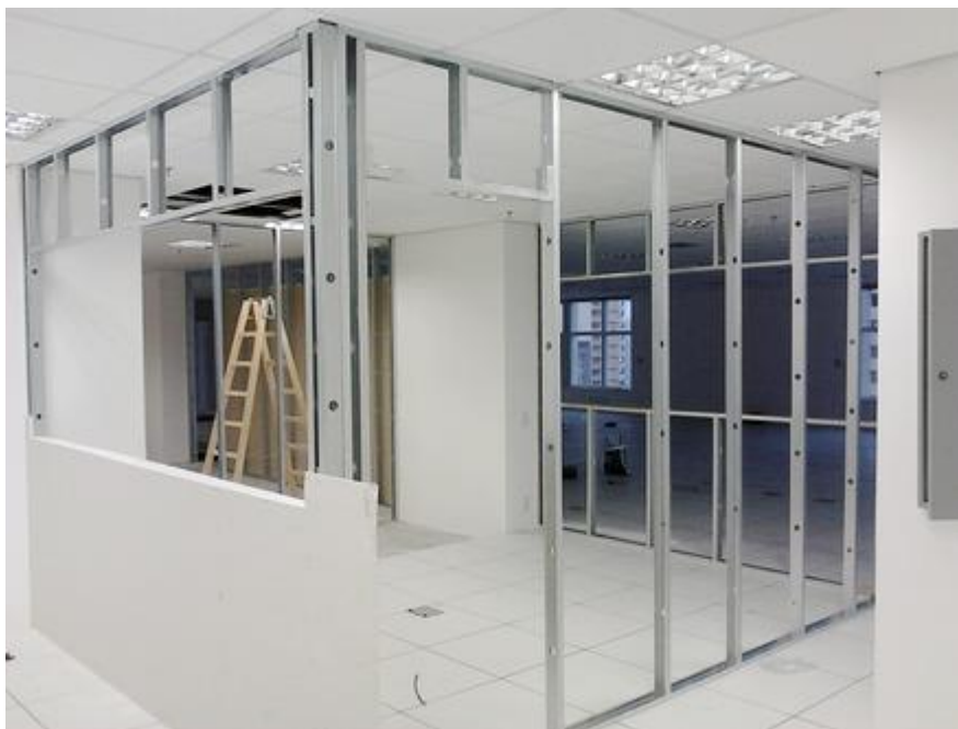
Figura 58: Perfis de alumínio instaladas.
