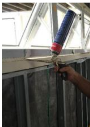
Figura 52: Aplicação de poliuretano nas janelas do container.
