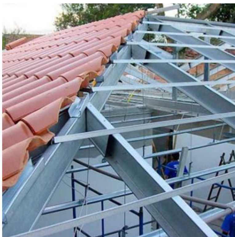
Figura 70: Implementação de telhado Steel Frame .
