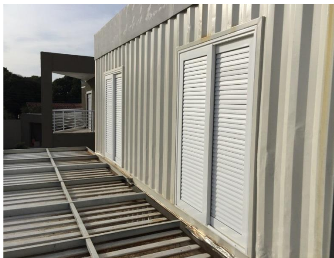
Figura 53: Exemplo das portas do container instaladas Fonte: Adaptado de GUIA CASA CONTAINER (2019)
