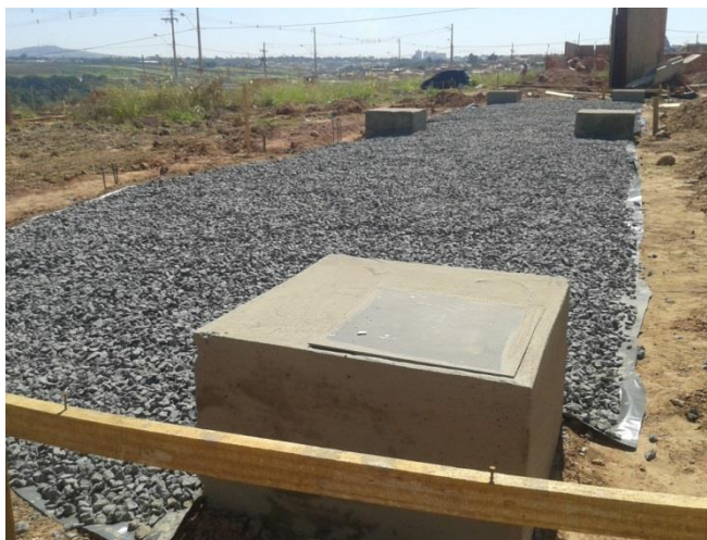
Figura 33: Terreno coberto com manta impermeável e brita.
