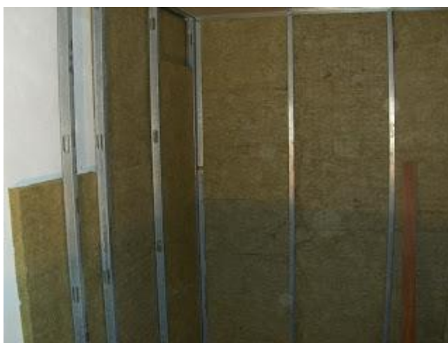
Figura 57: Instalação da lã de rocha.
