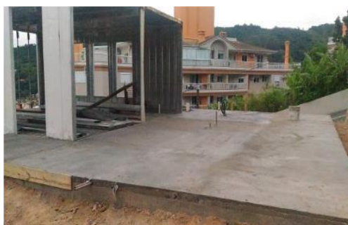
Figura 21: Implementação de radier em estruturas de casa container.
