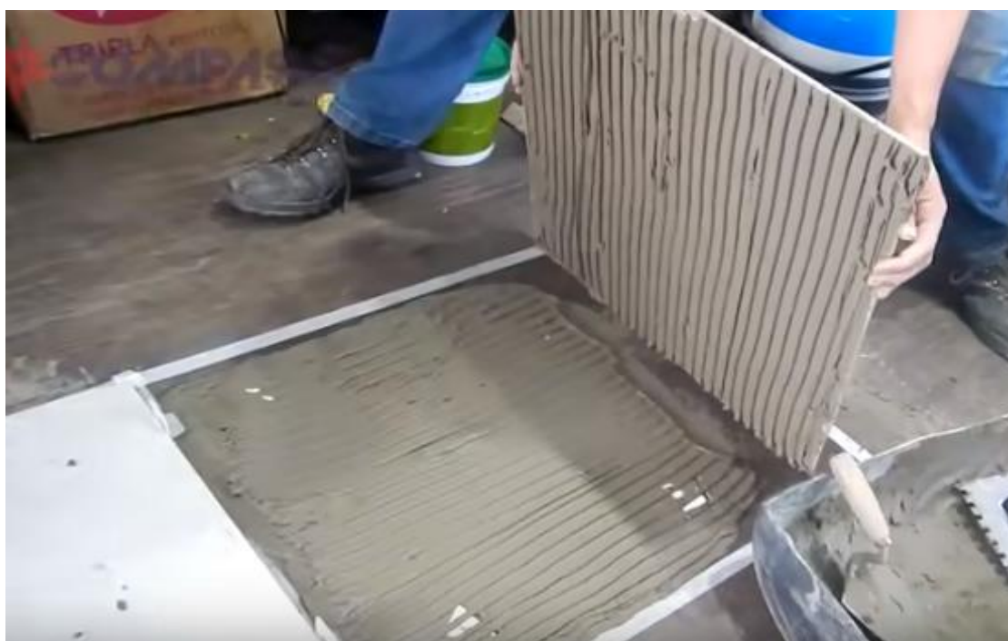
Figura 63: Aplicação de piso cerâmico sobre compensado naval
