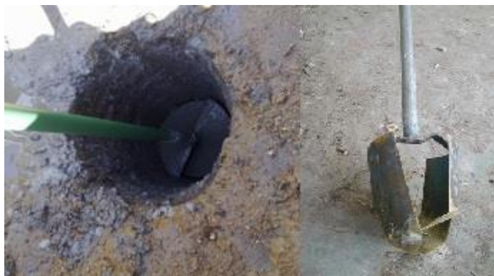
Figura 12 - Execução de estaca tipo broca com trado manual.
