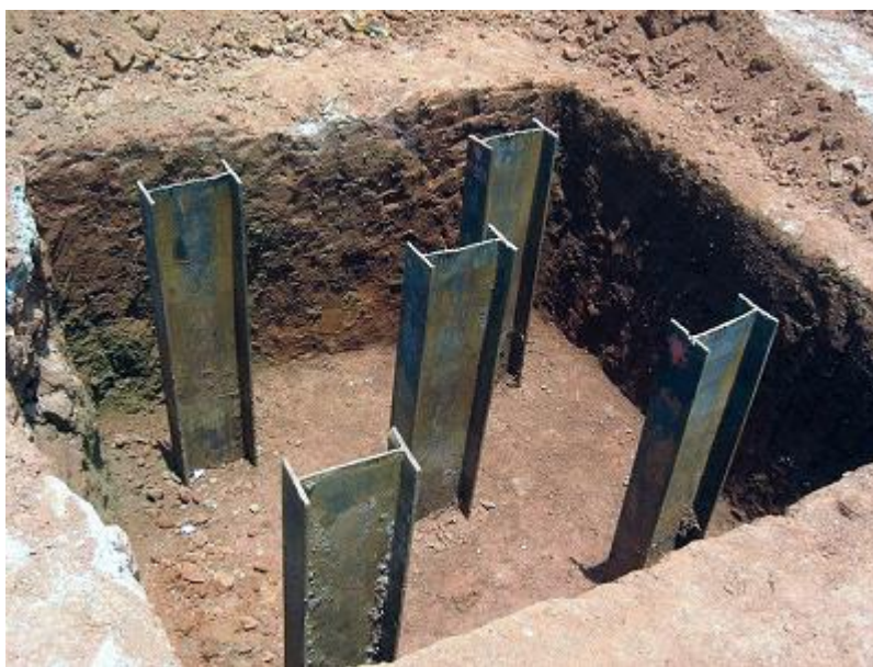
Figura 10 - Execução de estacas metálicas.
